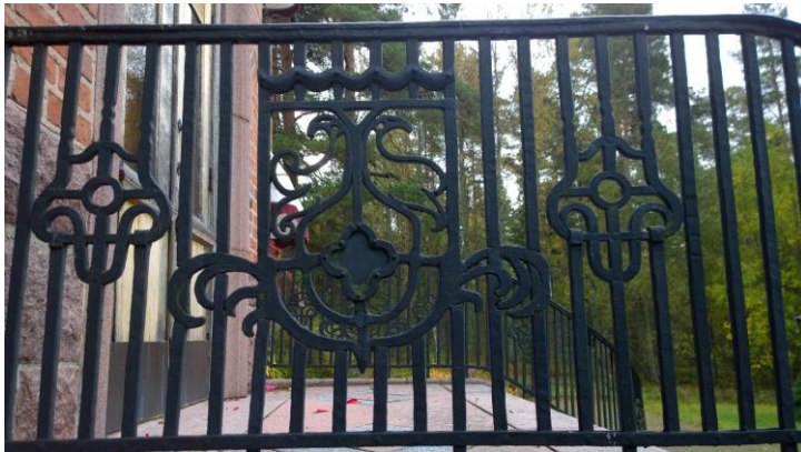
Kuva 19. Salin ulkopuolisten portaiden kaiteet
