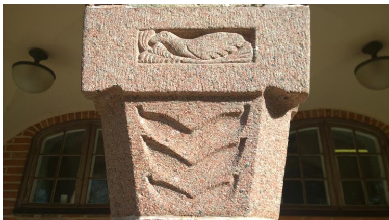
Kuva 10. Viktor Laurenin Uivat sorsat -reliefi terassin pylväiden päällä. 1914.
