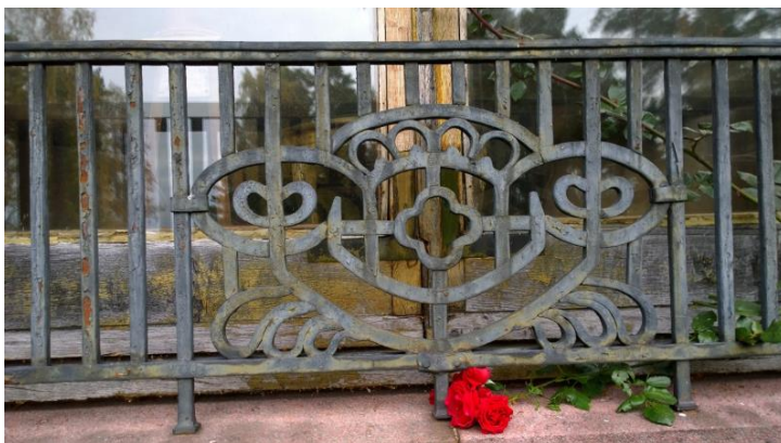
Kuva 20. Salien ikkunoiden kaiteet
