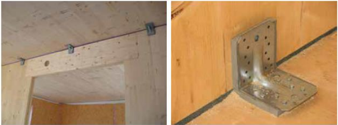
Kuvio 4. CLT-levyjä kiinnitettyinä kulmalevyillä toisiinsa (FPInnovations and Binational Softwood Lumber Council 2016)
