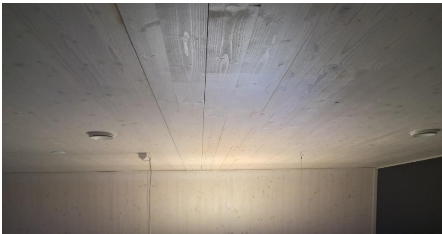
Kuvio 3. Halkeilua Kemin CLT-koetalon yläpohjassa
