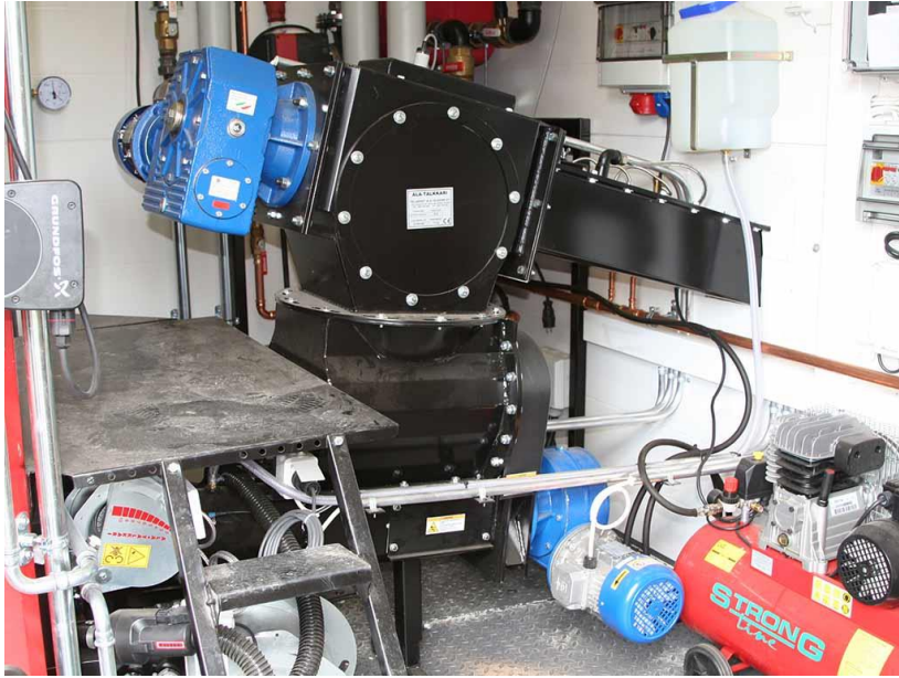
Kuvio 8. Pannuhuone, joka on varustettuna sulkusyöttimellä. (Ala-Talkkari 2016.)
