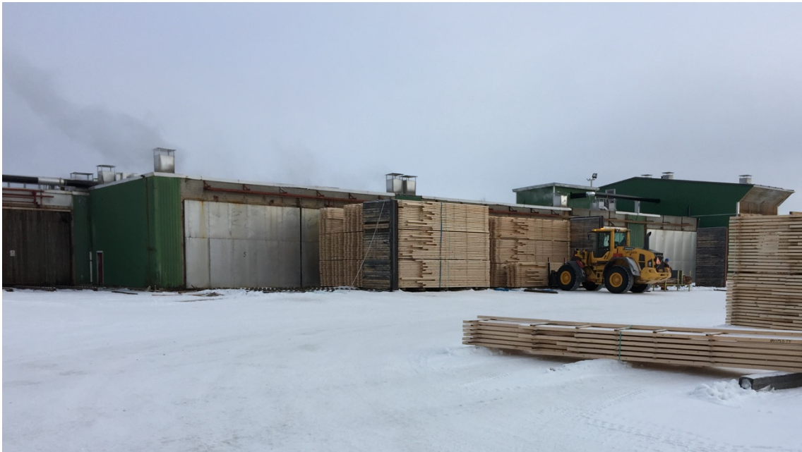
KUVA 4. Pyöräkone lastaamassa sahatavaraa vanhaan kuivaamoon
