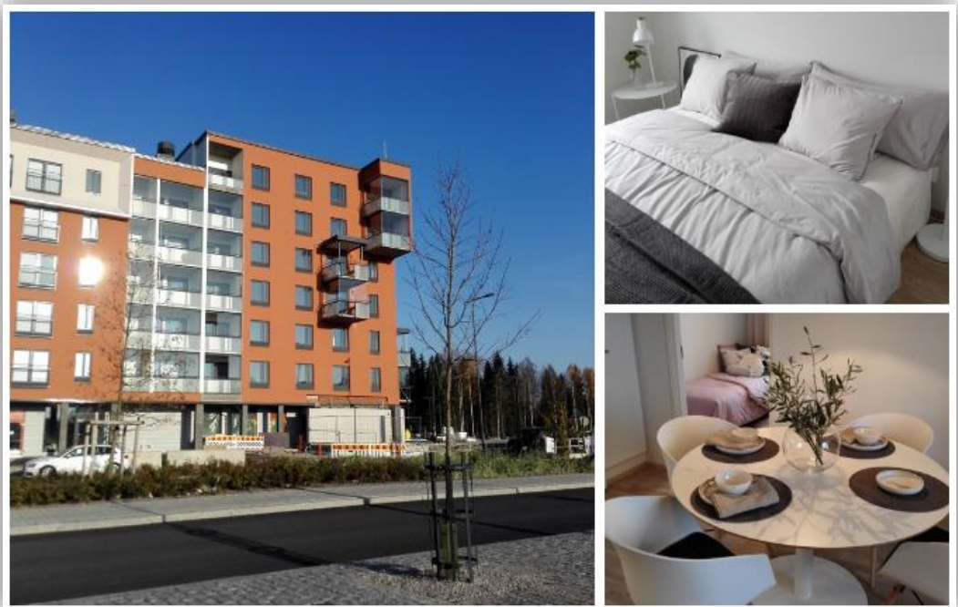
Kuva 17: Kuvakollaasi: Karneolin julkisivu ja sisätilat [41].
