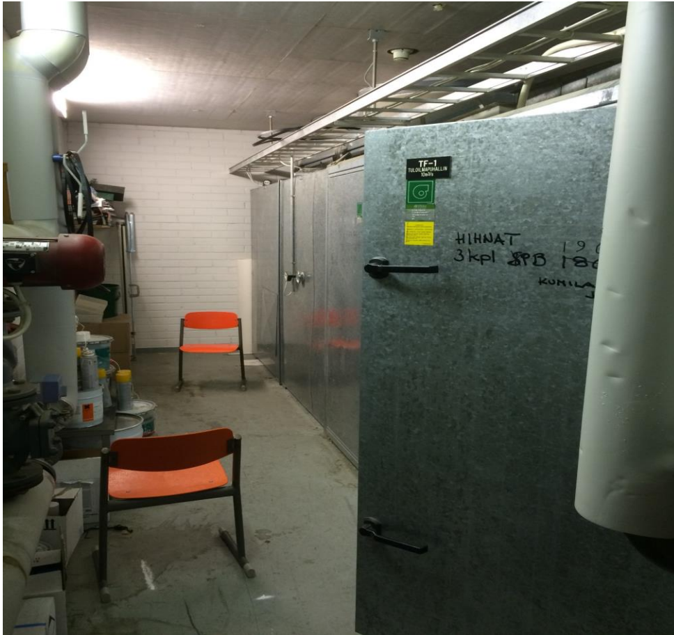
Kuva 9. Kotkan urheiluhallin ilmakonehuone. Antti Auervolle 2016.
