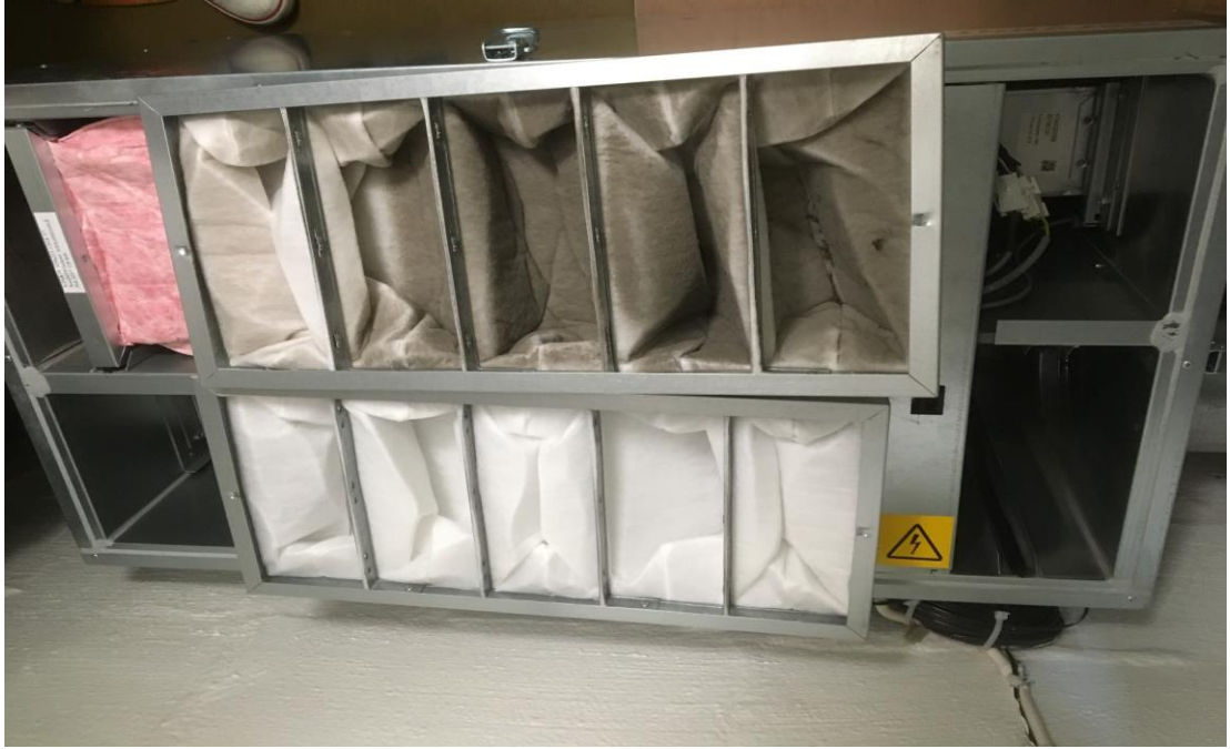
Kuva 12. Arto Tolsa -areenan ilmanvaihtokoneen vanha suodatin (ylhällä) ja uusi suodatin (alhaalla). Antti Auervuolle 2016.
