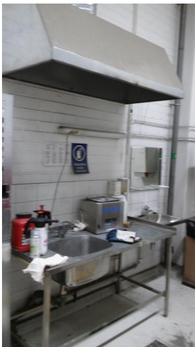
Kuva 34. Sähköverstaan kohdepoistollinen työskentelytila
