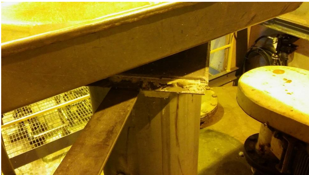
Kuva 28. Systemi vuotaa.
