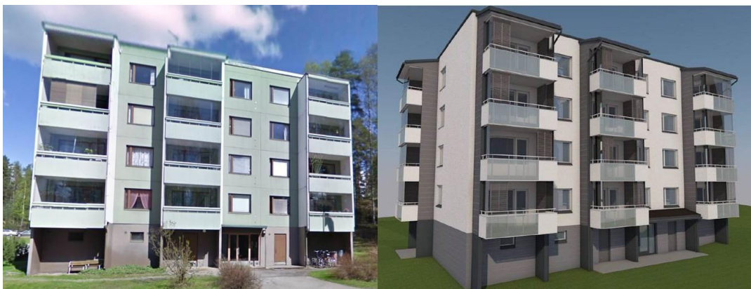
Kuva 25. Alkuperäinen ja kunnostettu rakennus, varustettuna lisälämmöneristyksellä ja uusilla suuremmilla parveketorneilla [Suomen Talokeskus Oy]
