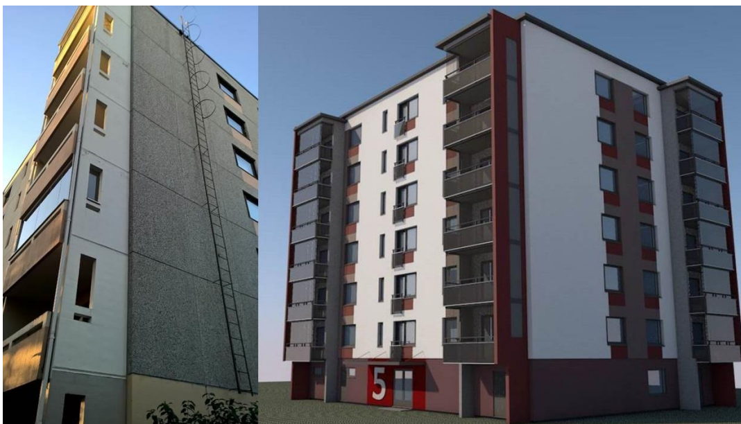
Kuva 26. Alkuperäinen ja kunnostettu rakennus, varustettuna lisälämmöneristyksellä ja uusilla suuremmilla parveketorneilla [Suomen Talokeskus Oy]
