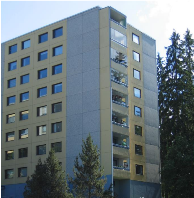
Kuva 19. Julkisivun kaareutuneita pesubetoni elementtejä [Kristian Koskenniemi]
