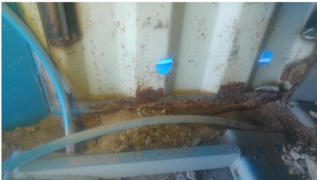
KUVA 7. Kontin seinä ennen työn aloitusta
