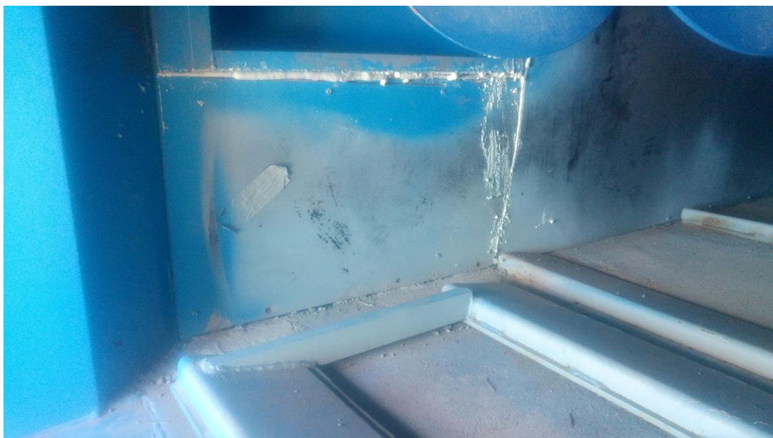
KUVA 8. Kontin seinä korjauksen jälkeen
