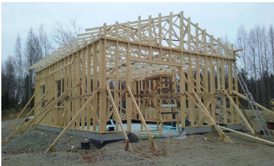
Kuva 25. Rakennuksen runko- ja vesikattotyöt aiheuttivat 24 % rakennuksen kokonaiskustannuksista. (Turunen 2016)
