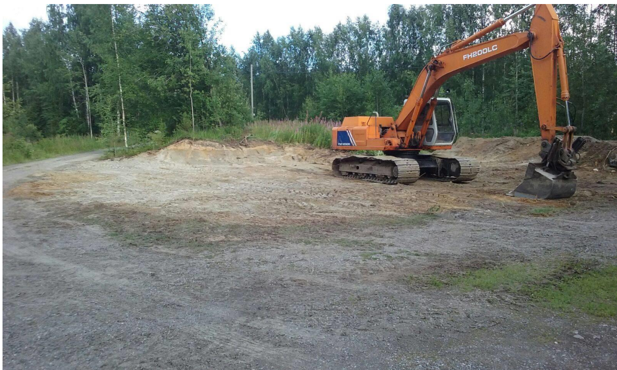
Kuva 4. Raivattu uudisrakennuksen paikka (Turunen 2016)
