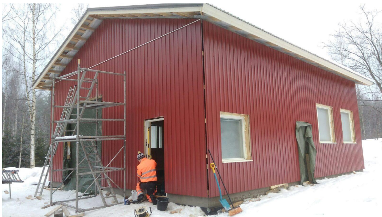
Kuva 20. Pystyyn asennettu profiilipelti on kustannustehokas julkisivumateriaali. (Turunen 2017)
