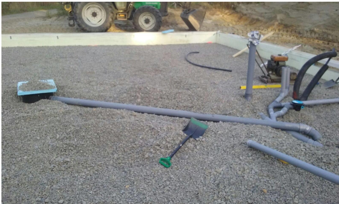
Kuva 24. Vasemmalla kuvassa öljynerotuskaivo asennusvaiheessa (Turunen 2016)
