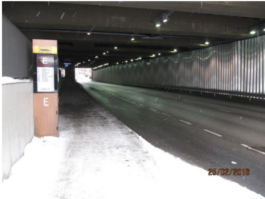
Kuva 33. Paikallisliikenteen E-pysäkki siltakannen alla asiakkaan näkökulmasta (Tuomenoja 2016).
