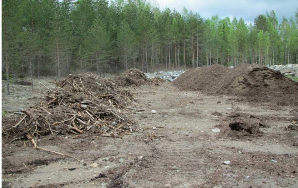
Kuva 4. Kuvassa oikealla on valmista seulottua kunntaa. Kuvassa vasemalla on seulonnan yhteydessä poistetut juuret, oksat ja kivet (Mähönen 2016).
