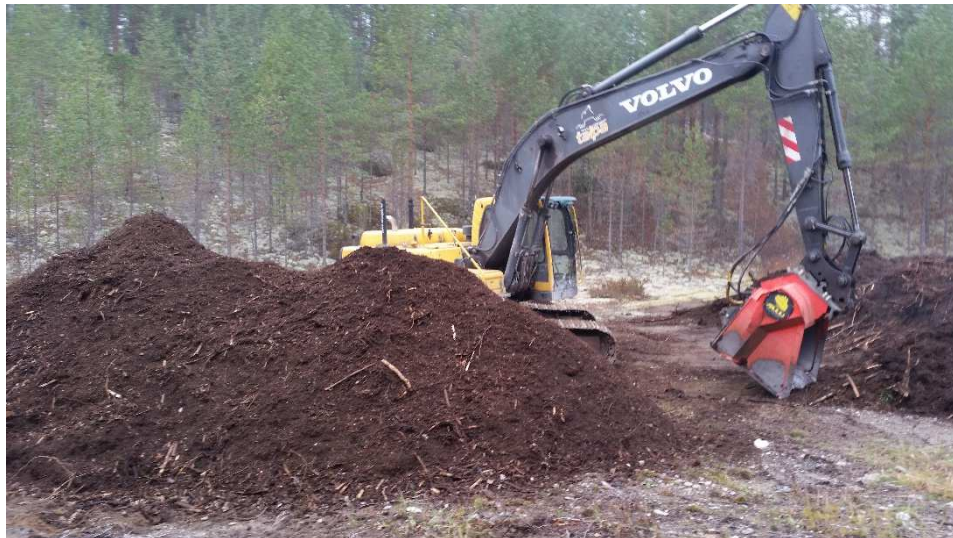
Kuva 2. Kunnan murskausta/seulontaa läheisellä varastointialueella (Muuronen 2015).
