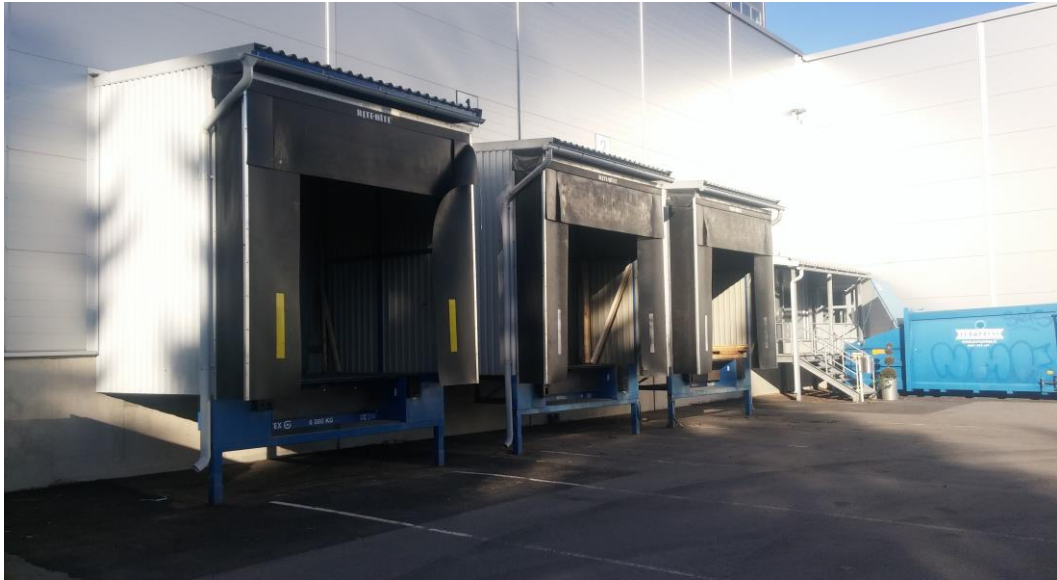
Kuva 2. Kuormaustiloja mekaanisella tiivistyksellä.
