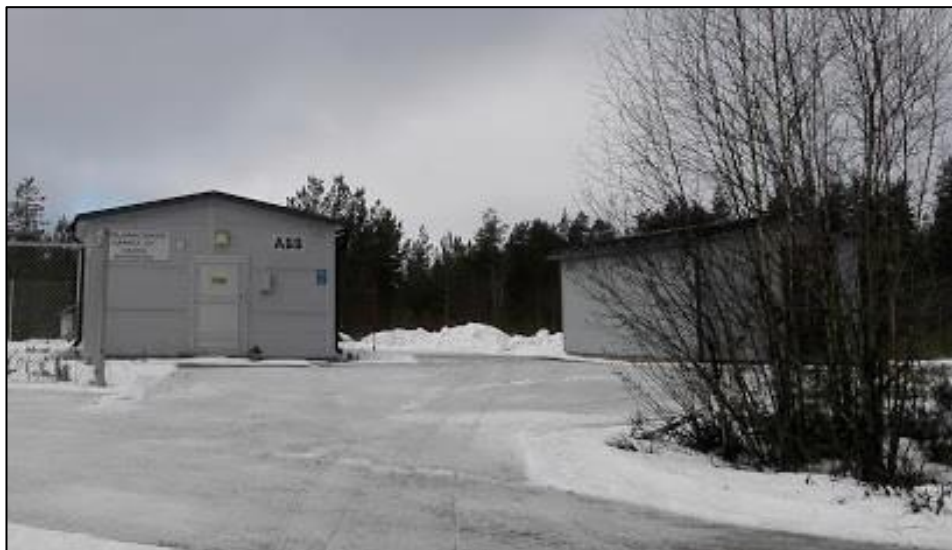
Kuva 4. Hongon sähköaseman rakennukset
