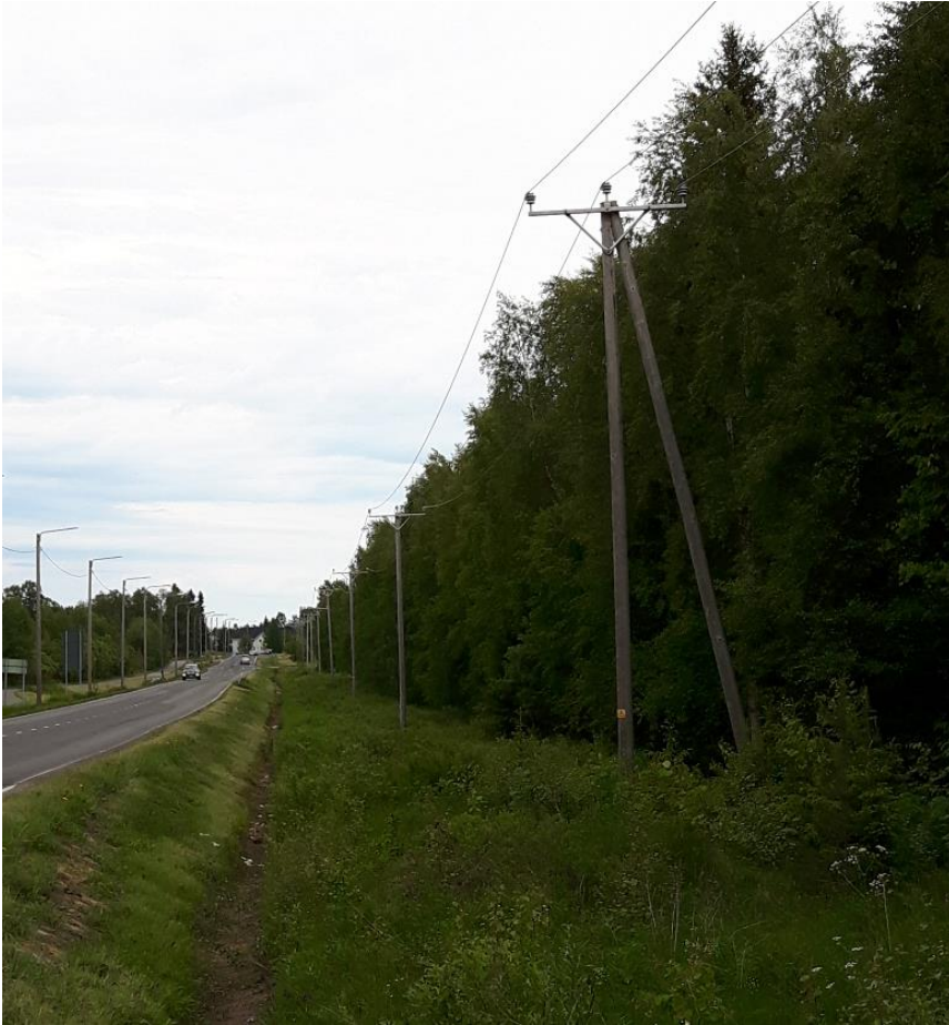
KUVA 2. KJ-avojohto tien varressa (Lehtosaari 2016)
