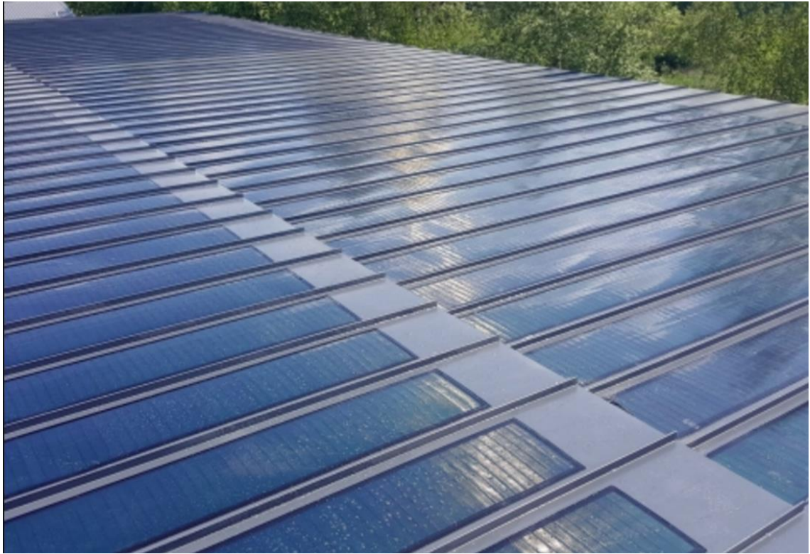
Kuva 31. Ohutkalvopaneelin ja kattopellin yhdistelmä (Virte-Metalli Oy 2016).
