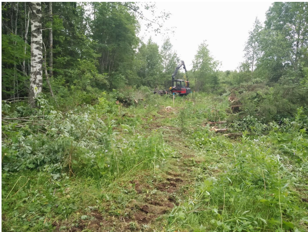
KUVA 5. Tamma-ahontien raivaustyöt (Hottinen Esa 2016)
