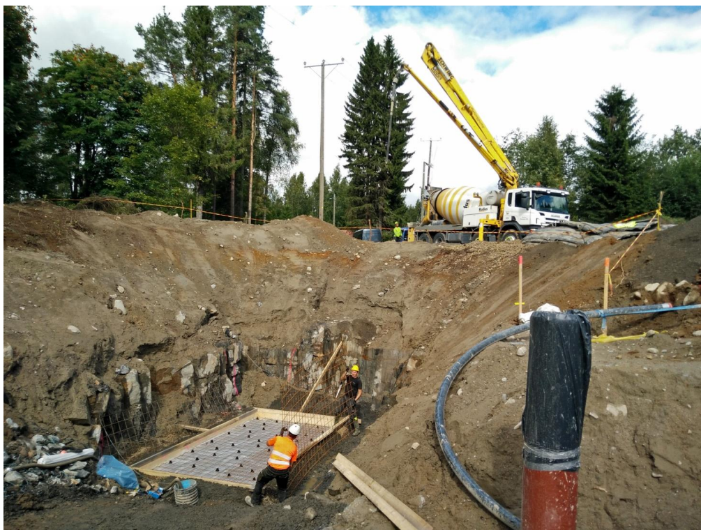
KUVA 11. Jätevesipumppaamon perustusten rakentaminen (Hottinen Esa 2016)
