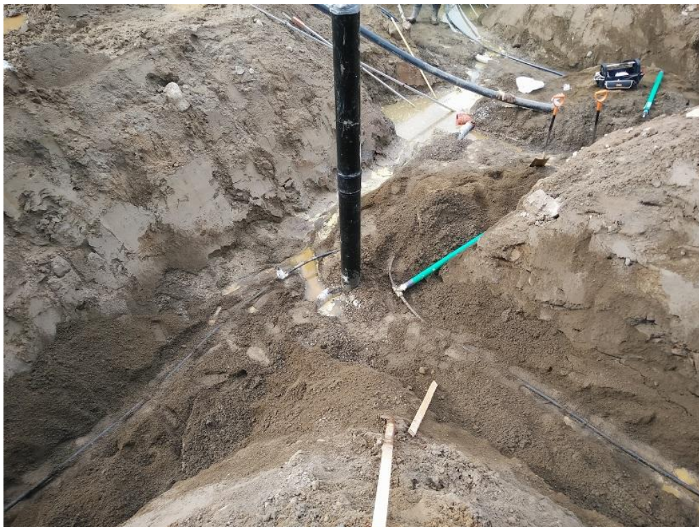
KUVA 9. Tamma-ahontien vesihuollon rakentamista (Hottinen Esa 2016)
