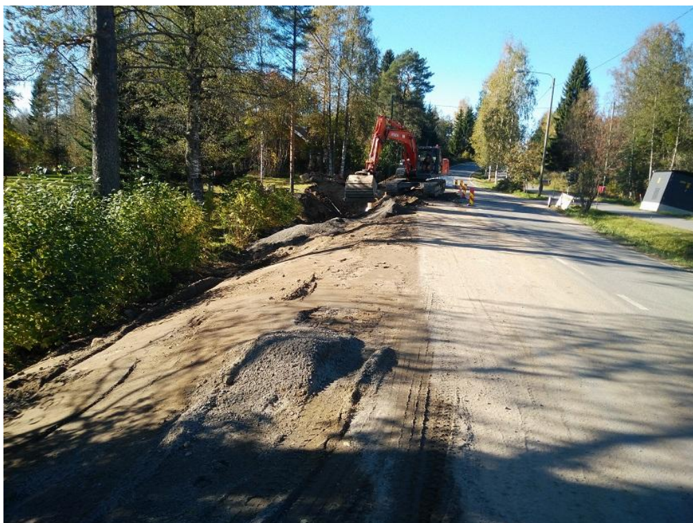
KUVA 10. Kurkimäentien vesijohdon ja viemäriin liitostyöt (Hottinen Esa 2016)
