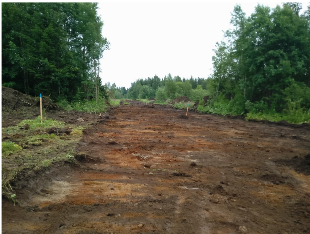
KUVA 6. Tamma-ahontien pintamaanpoisto (Hottinen Esa 2016)
