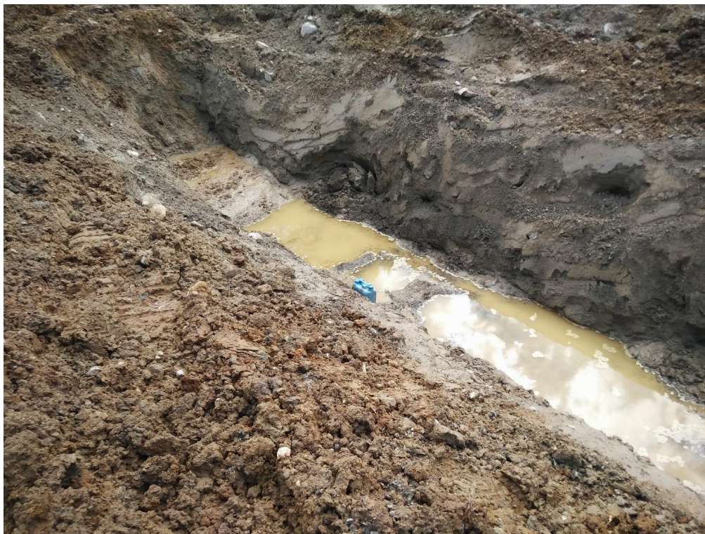
KUVA 7. Tamma-ahontien vesihuollon kanaalikaivua (Hottinen Esa 2016)
