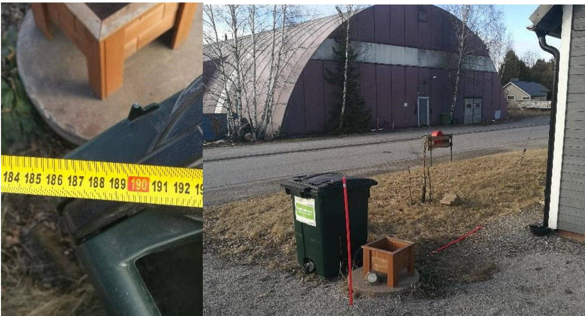
Roska-astia sijoitettu liian lähelle rakennusta.
