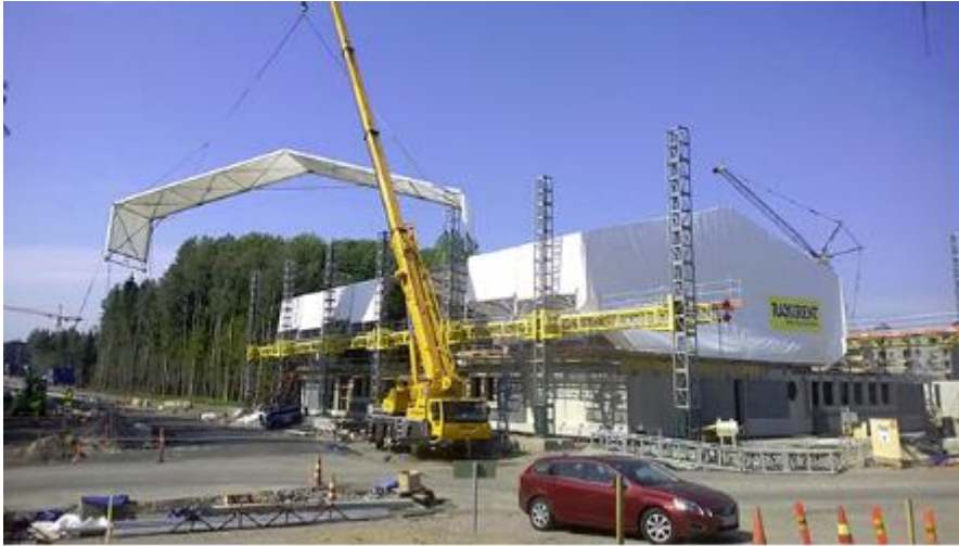
KUVA 3. Koko rakennuksen peittävä sääsuoja (6)
