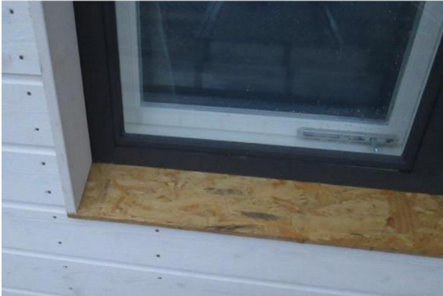
KUVA 4. Ikkunan alalaidan suojaus vanerilla (12)
