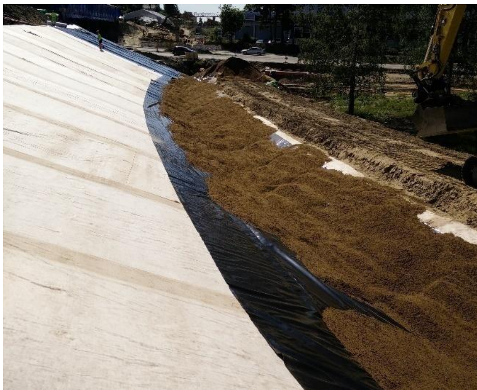
Kuva 19. S6 pohj. puolen pohjavedensuojaus alkuperäisten suunnitelmien mukaisesti.
