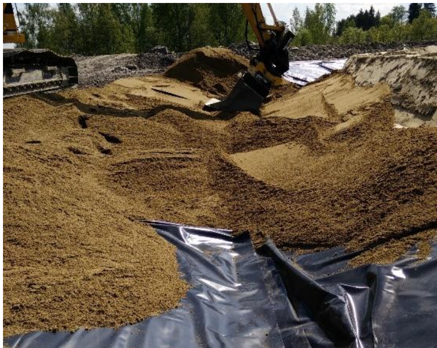
Kuva 6. Suojahiekan levitys ohutmuovin päälle. Tapaninen Miika 2016
