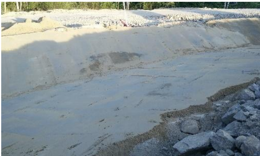
Kuva 2. Bentoniittimattorakenteen alusta. Tapaninen Miika 2016
