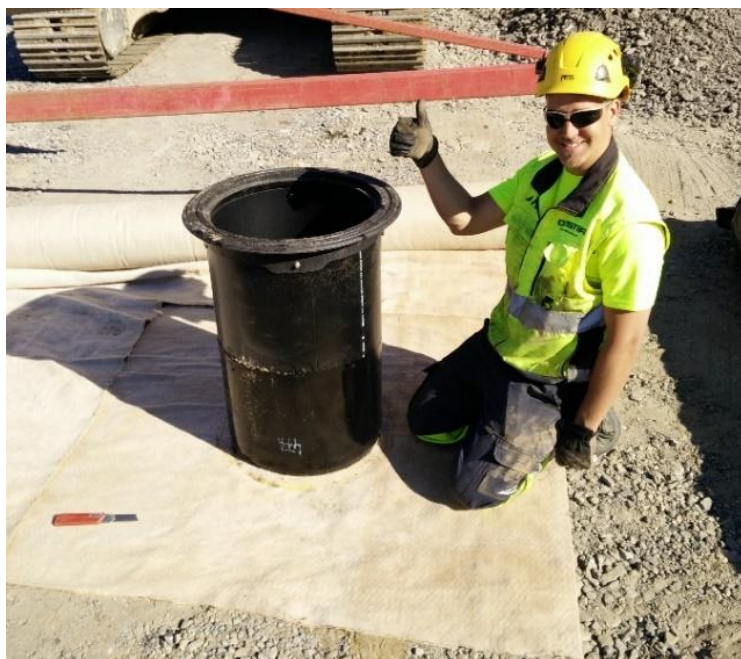
Kuva 15. Bentoniittimaton läpiviennin tiiviyyden varmistus. Tapaninen Miika 2016
