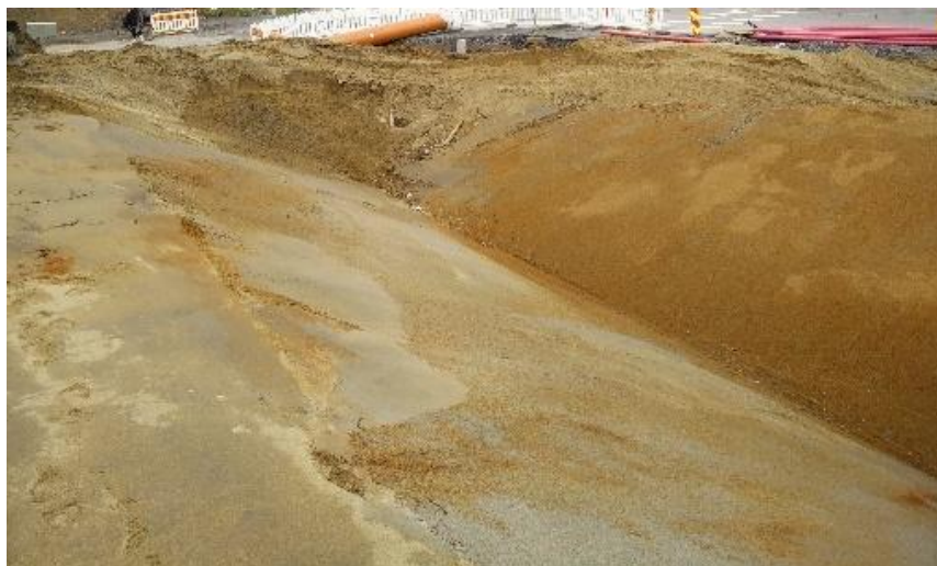
Kuva 1. Bentoniittimattorakenteen alusta. Tapaninen Miika 2016
