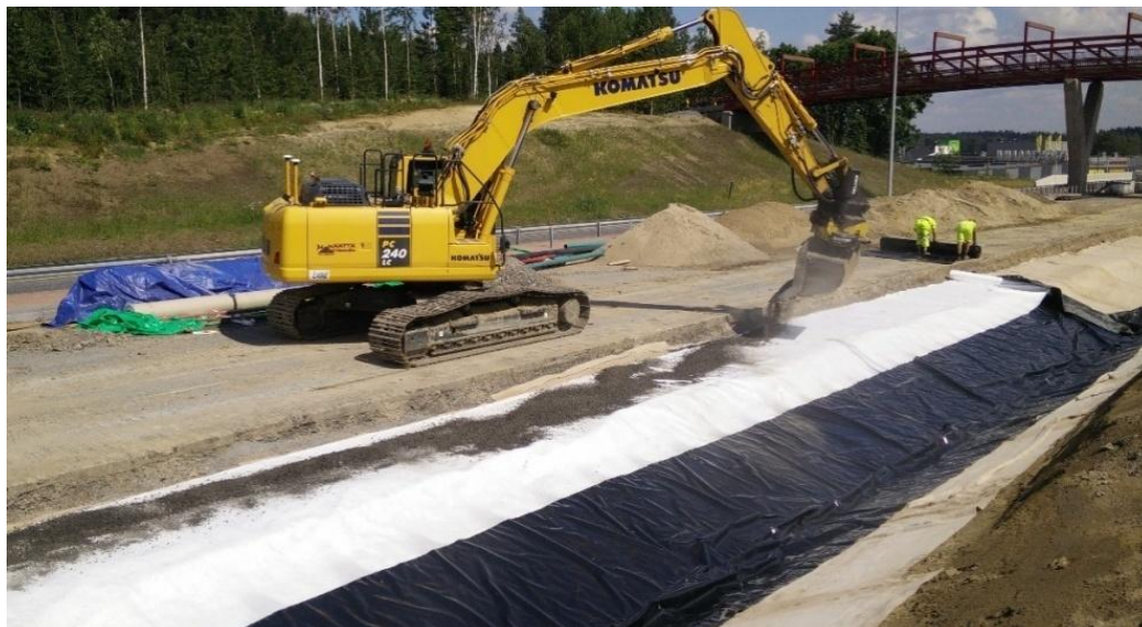
Kuva 16. Suodatinkangas asennettuna ohutmuovin päälle tien reunaan. Tapaninen Miika 2016
