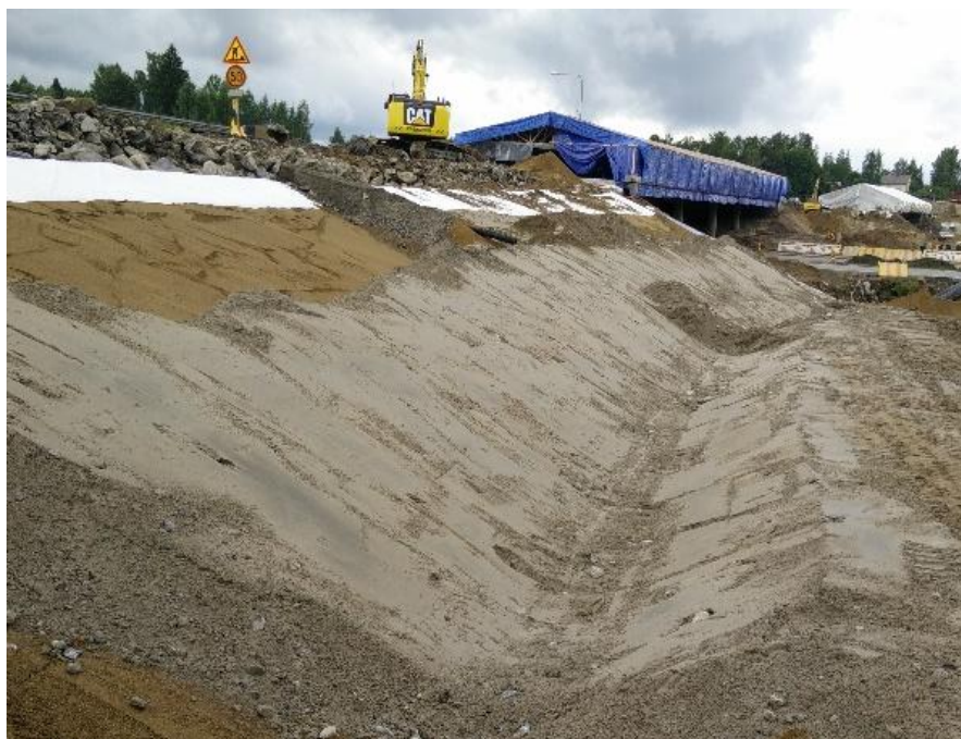
Kuva 7. Suojamaan levitys suojahiekan päälle. Tapaninen Miika 2016
