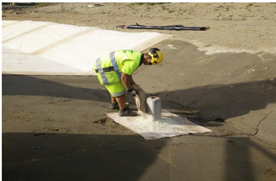
Kuva 9. Liikennemerkkin jalan läpiviennin tiiviyyden varmistaminen bentoniittijauholla. Tapaninen Miika 2016
