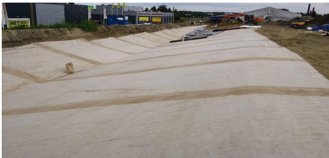
Kuva 8. Bentoniittimatton asennus poikittain. Tapaninen Miika 2016
