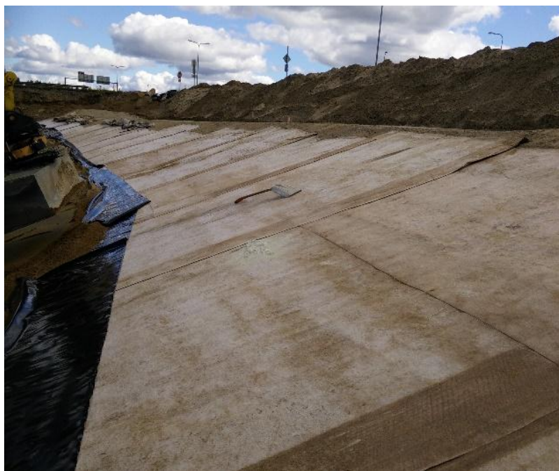
Kuva 20. S6 pohj. puolen pohjavedensuojauksen korjaustyöt. Tapaninen Miika 2016
