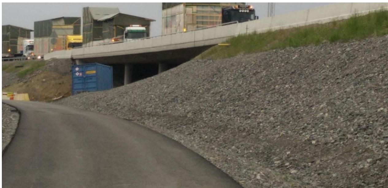
Kuva 18. 90 mm murskeella toteutettu ojan luiskan verhous S5-S6 välillä. Tapaninen Miika 2016
