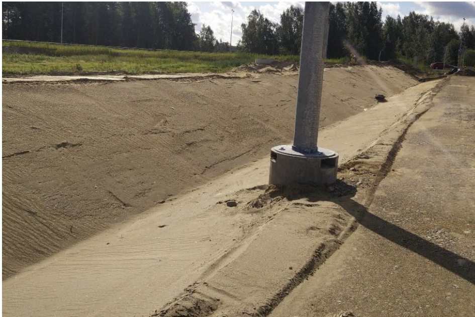
Kuva 14. Portaalin jalka asennettuna bentoniittimattorakenteen pohjan alle.
