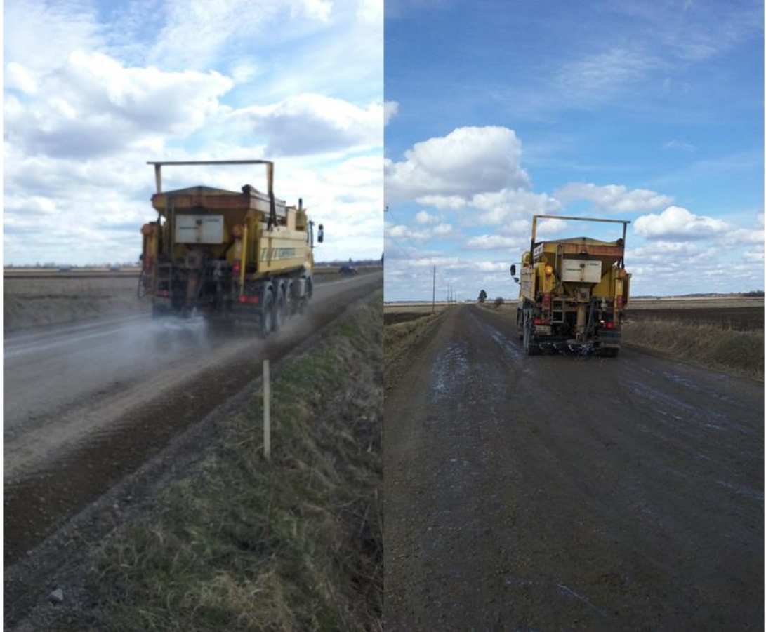
Kuva 7. Vasemmalla kuivan materiaalin ja oikealla liuoksen levitys Jokitiellä
