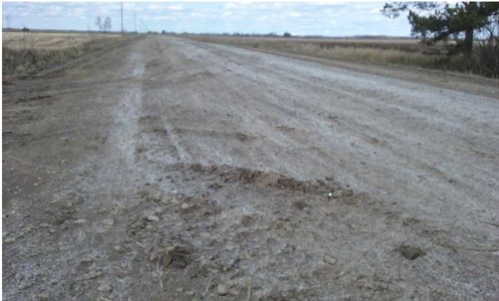
Kuva 4. Biopolymeerien levitystä Jokitielle 24.5.2016
