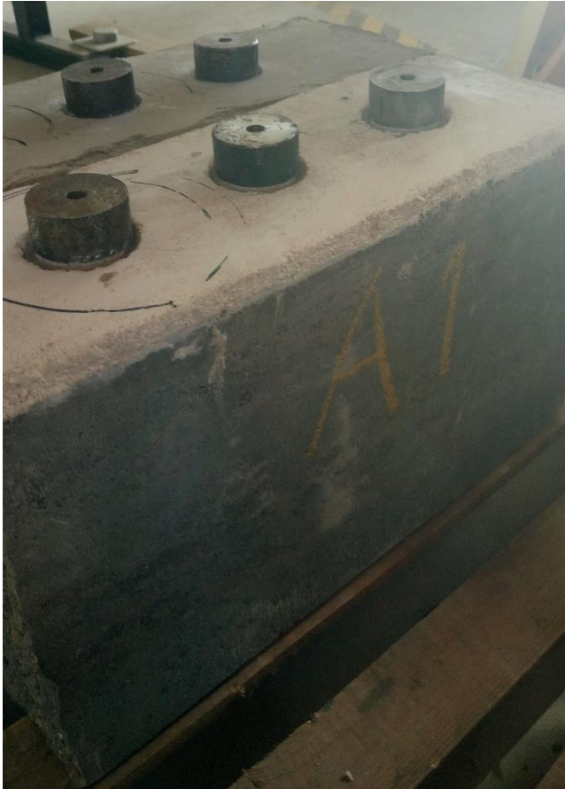
Kuva 14. Vetolaikat liimattuna laastiin
