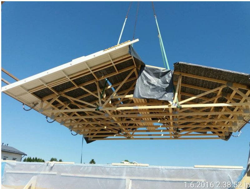
KUVA 1. Kattoelementin nosto paikalleen
