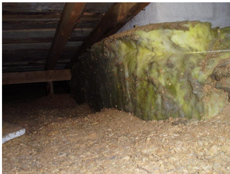
KUVA 15. Eristys piipun ympärillä
