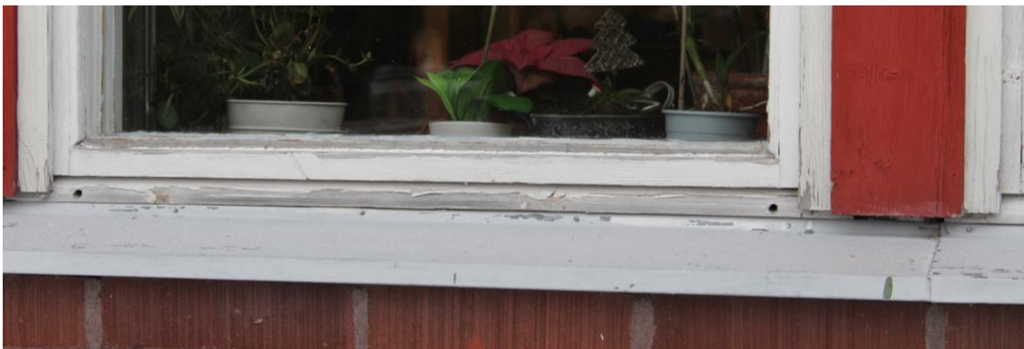
KUVA 34. Olohuoneen ikkuna rakennuksen eteläpäädyssä
