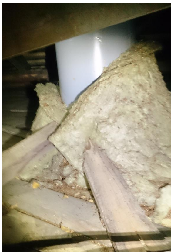
KUVA 11. Eristys piipun ympärillä
