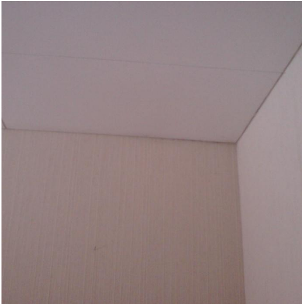
11. MH2 ja autotallin välinen seinä
