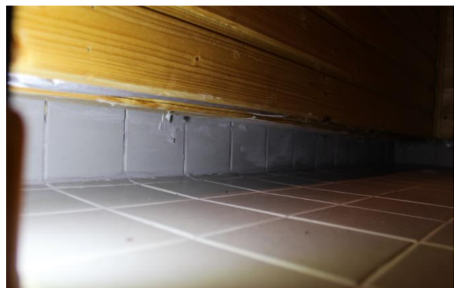
KUVA 31. Takaseinän alareuna koteloitu
