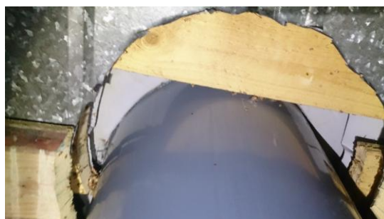
KUVA 13. Läpivienti vesikatteen läpi
