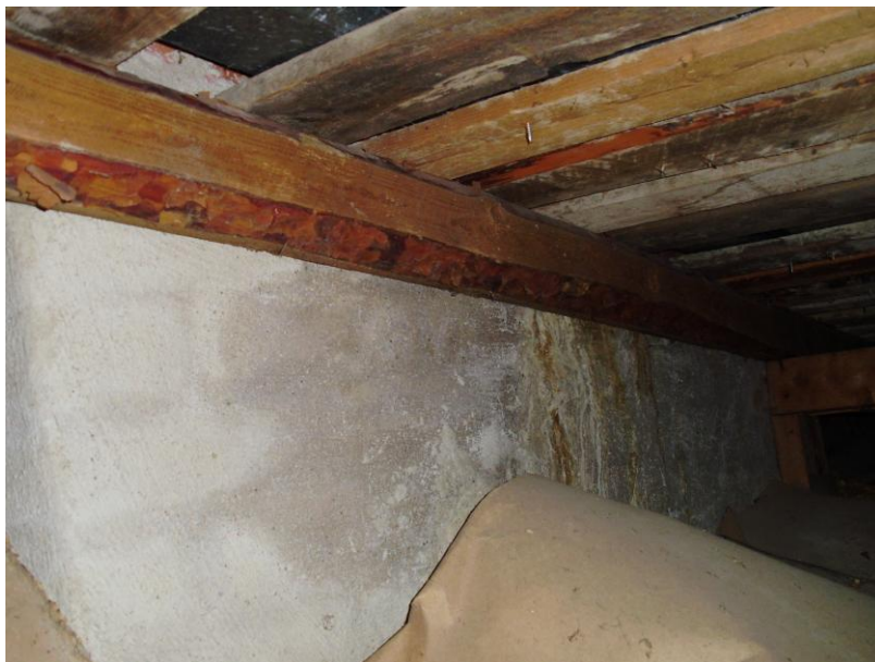
KUVA 16. Veden aiheuttama värjäymä piipussa
