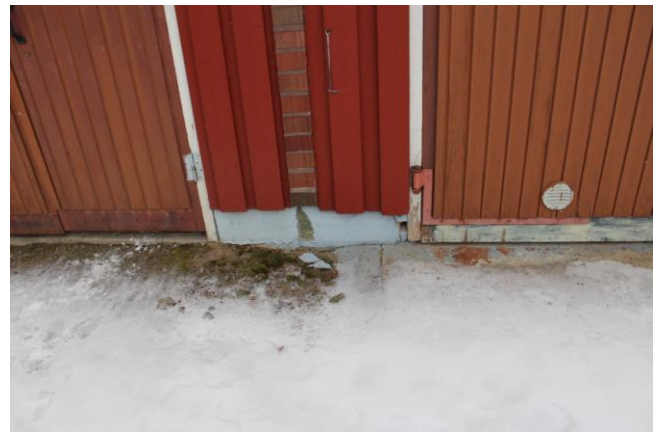
KUVA 38. Vanhan rakennuksen ja laajennuksen liitoskohta
