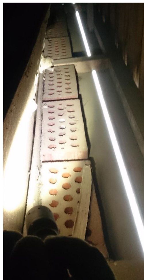
KUVA 22. Tiilet kiinni tuulensuojassa
