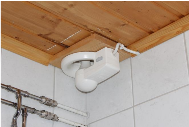
KUVA 40. Kylpyhuoneen poistoilmapuhallin KUVA 41. Makuuhuoneen välioivi
