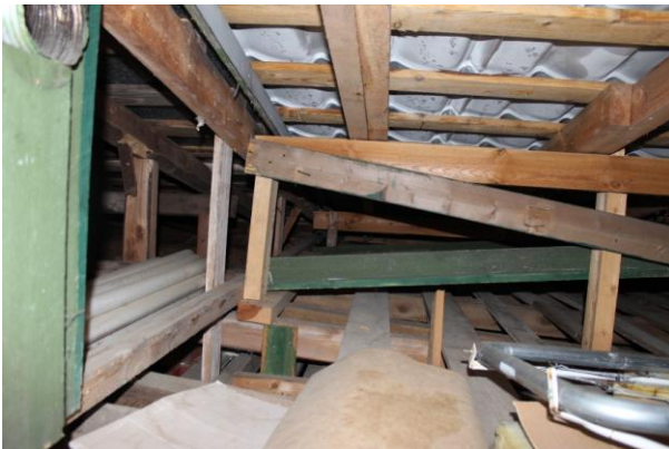
KUVA 6 . Vanhan rakennuksen ja laajennuksen saumakohta
