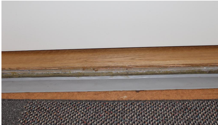
KUVA 27. Pukuhuoneen ja kylpyhuoneen välinen kynnyks
