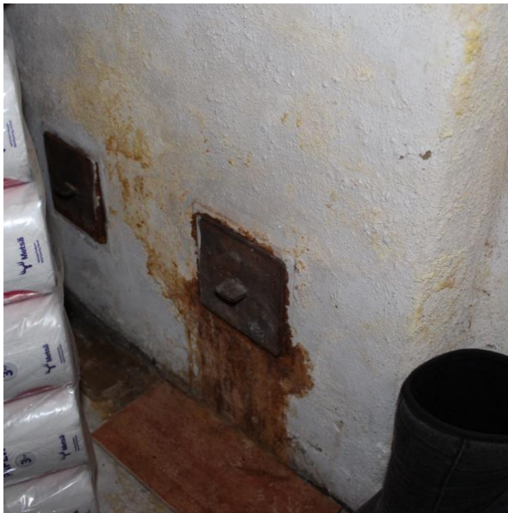
KUVA 33. Piipun nuohousluukku
