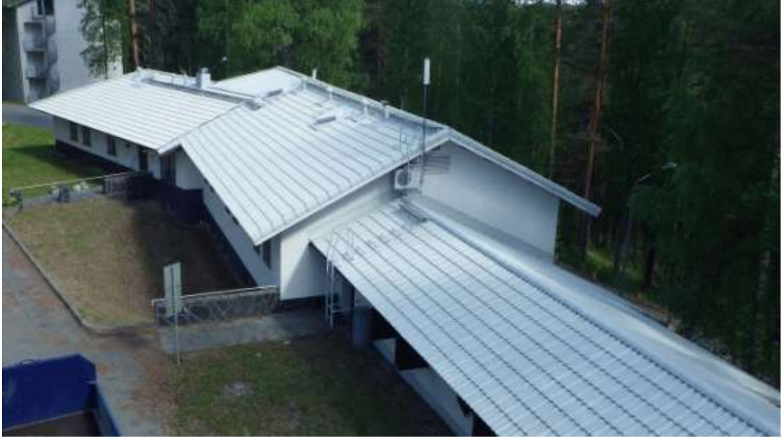
Kuvio 11. Tiilikatto pinnoituksen jälkeen. (Kumpulainen 2017.)
