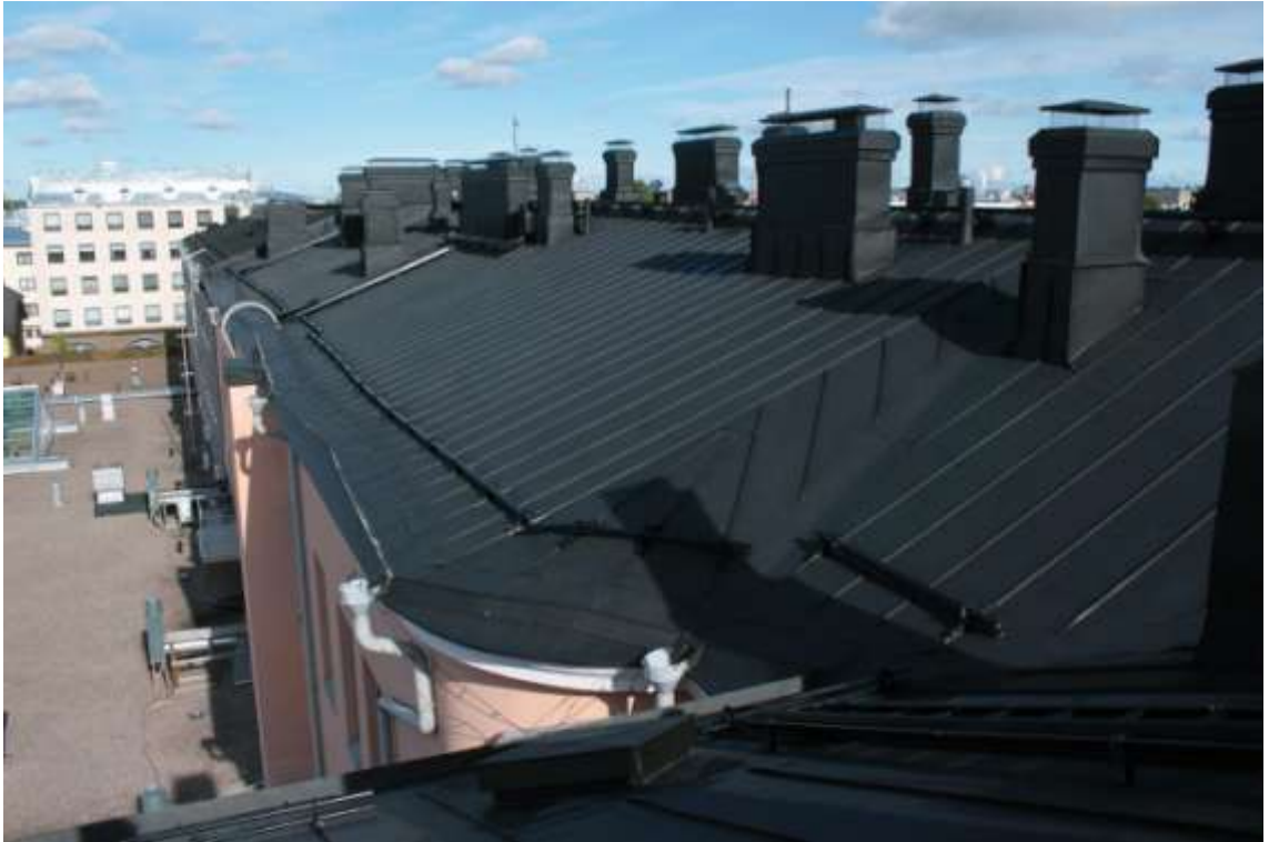
Kuvio 6. Sinkitty peltikatto maalauksen jälkeen. (Kumpulainen 2017.)
