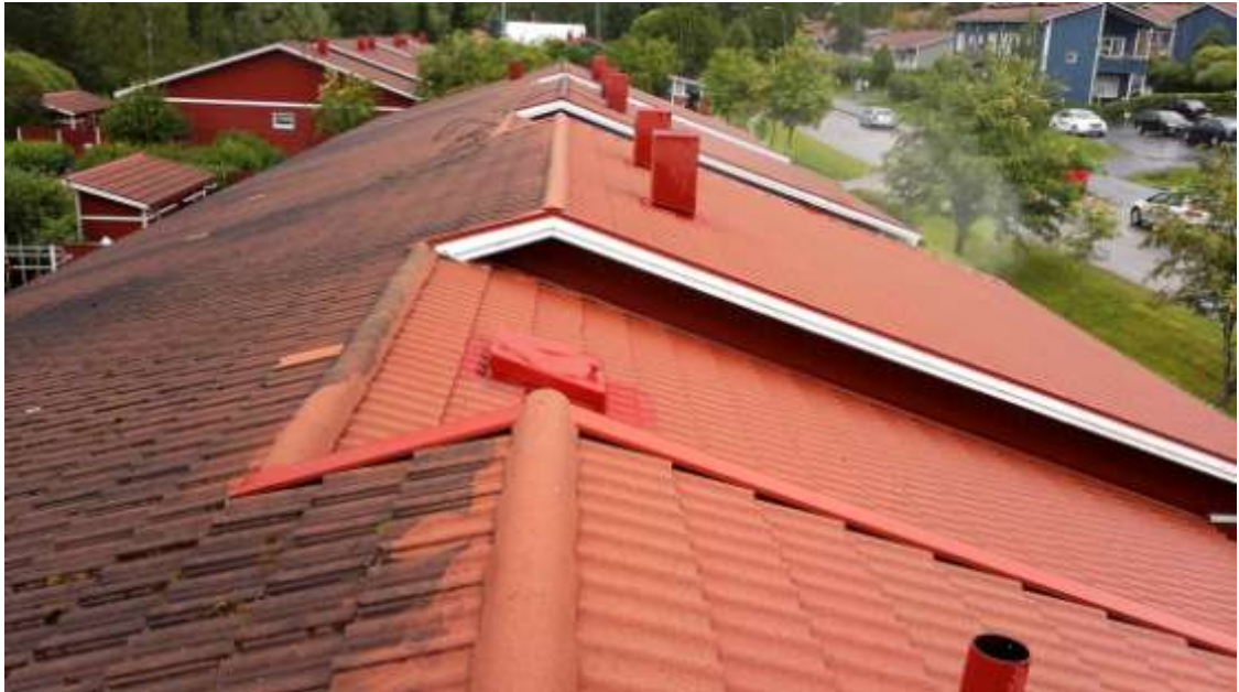
Kuvio 4. Osittain puhdistettu tiilikatto. (Kumpulainen 2017.)
