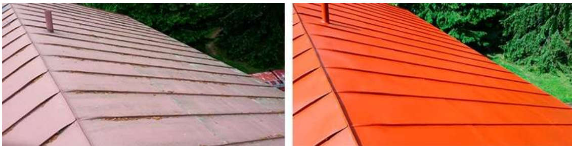
Kuvio 8. Huoltomaalauskohte ennen ja jälkeen. (Katon maalaus – peltikaton huoltomaalaus 2016.)
