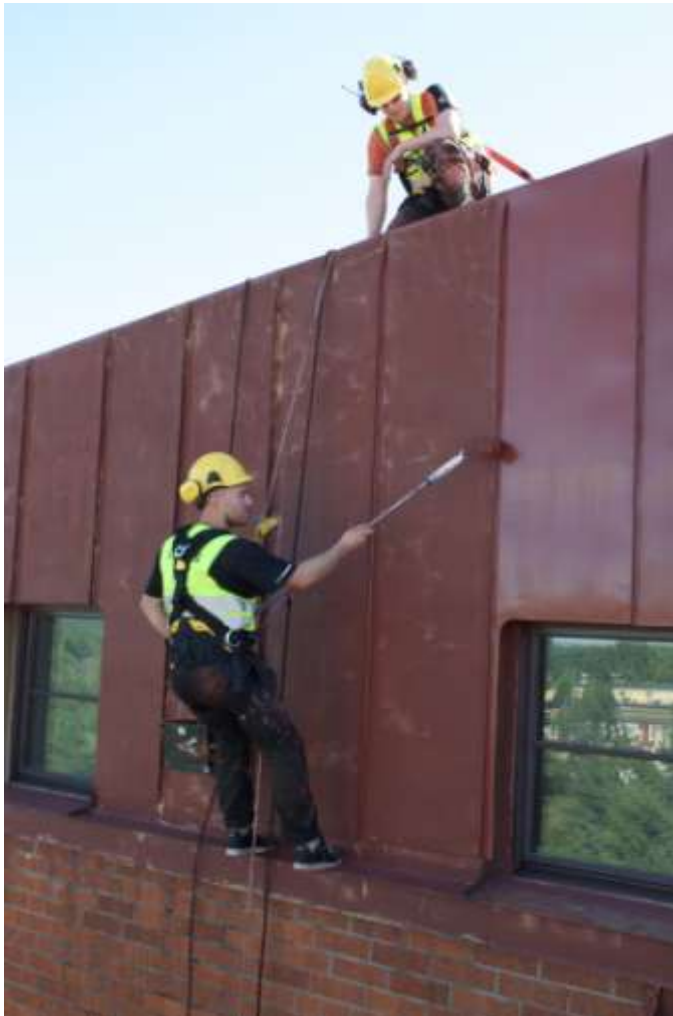
Kuvio 12. Henkilökohtaisen putoamissuojauksen käyttöä. (Kumpulainen 2017.)
