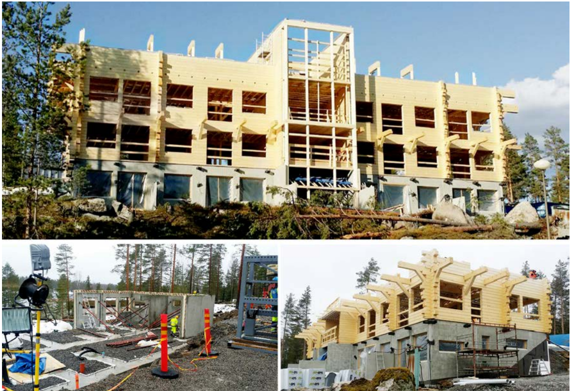
KUVA 10. Ähtäriin valmistuneen hirsirunkoinen puukerrostalo rakentamisvaiheessa (28, muokattu).
