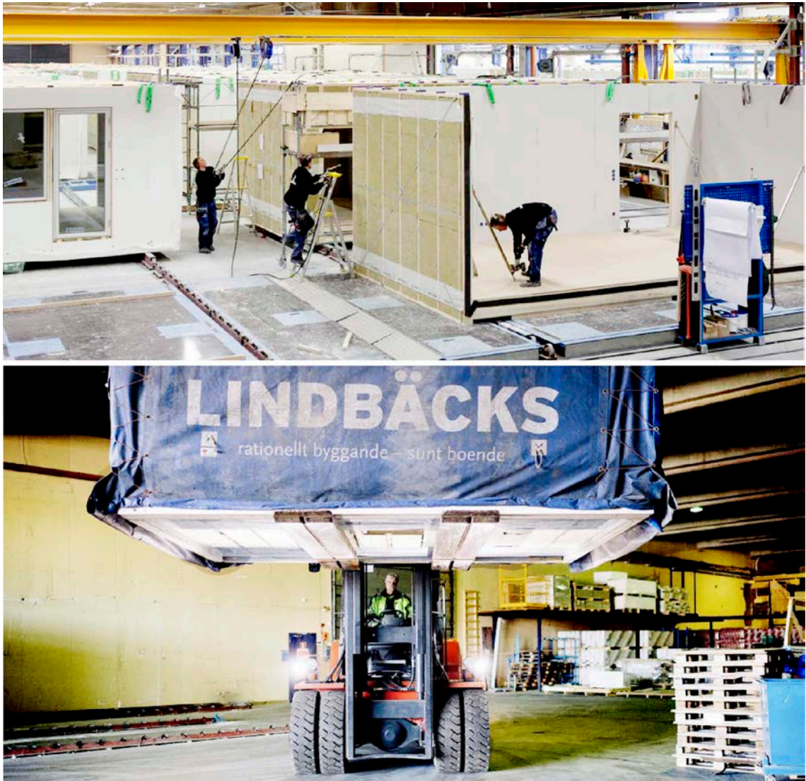
KUVA 28. Tilaelementit valmistetaan tehtaalla, jonka jälkeen ne paketoidaan huolellisesti (73; 74, muokattu).
