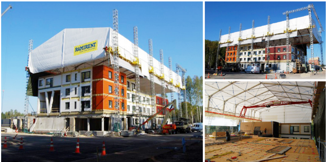
KUVA 15. PuuMerassa elementtiasennus suoritettiin kokonaan teltan suojissa (34, muokattu).
