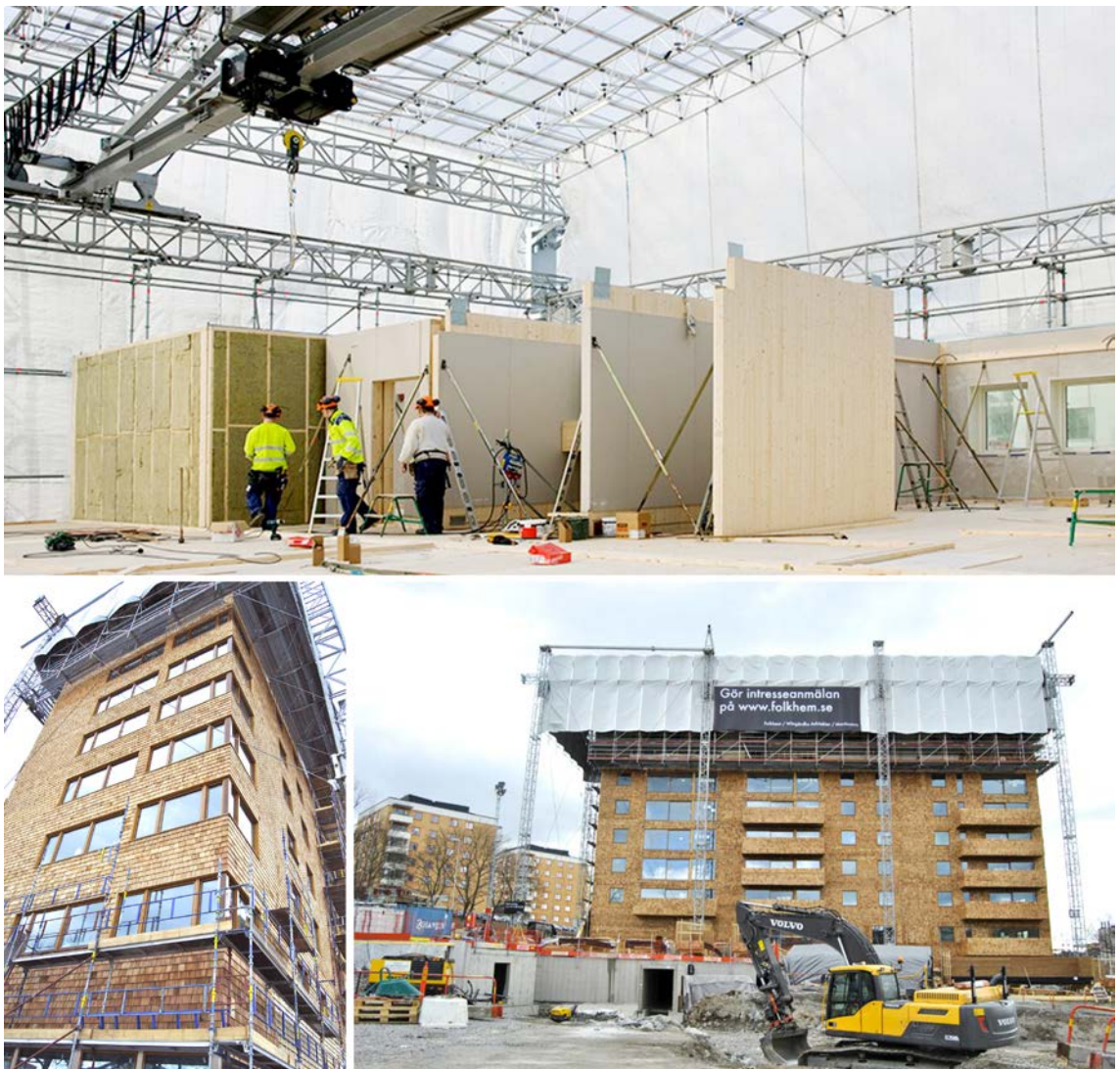
KUVA 30. Strandparkissa elementtien asennus tehtiin teltan alla (78; 79, 30, muokattu).
