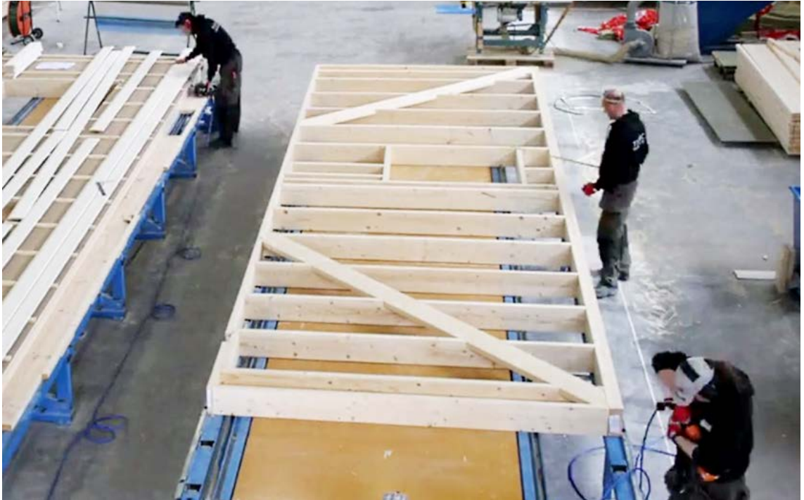
KUVA 5. Rankarunkoisen elementin valmistus Timbeco woodhouse:n tehtaalla (22).
