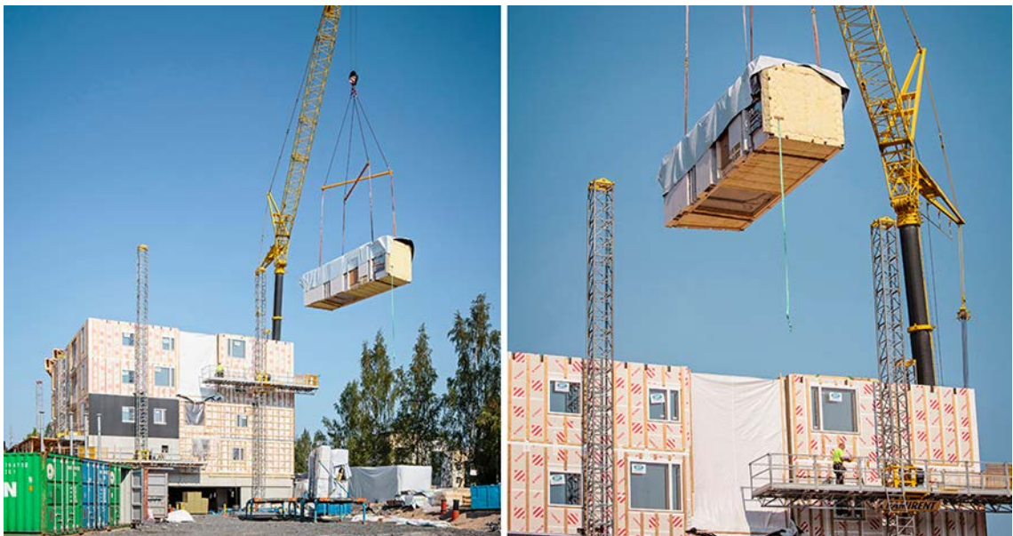
KUVA 22. Tilaelementin nosto Puukuokka yhden rakentamisvaiheessa (43).
