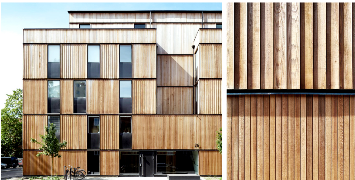
KUVA 36. Punasetriä on hyödynnetty julkisivussa eri levyisinä paneelina (81, muokattu).
