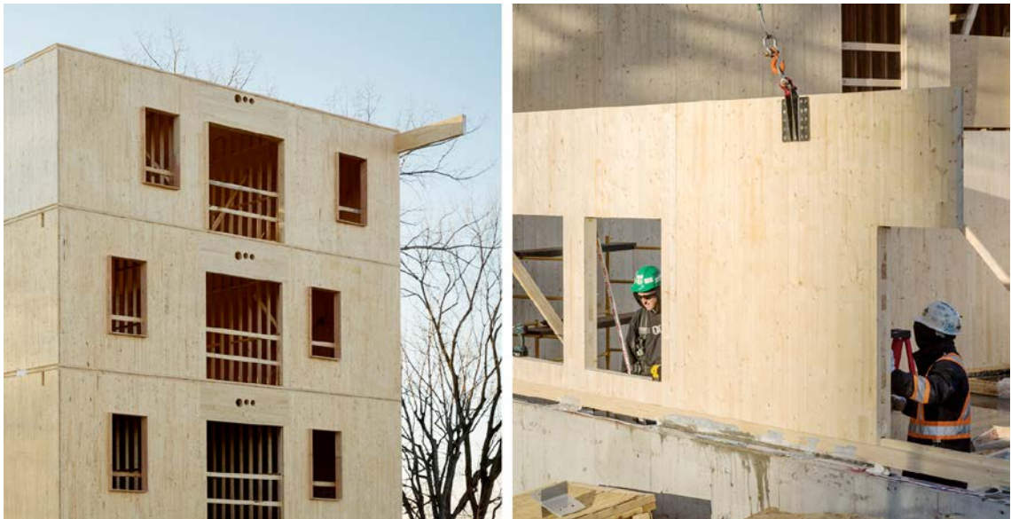
KUVA 8. Esimerkki CLT-elementillä rakennetusta kerrostalon rungosta Kanadassa (24, muokattu).
