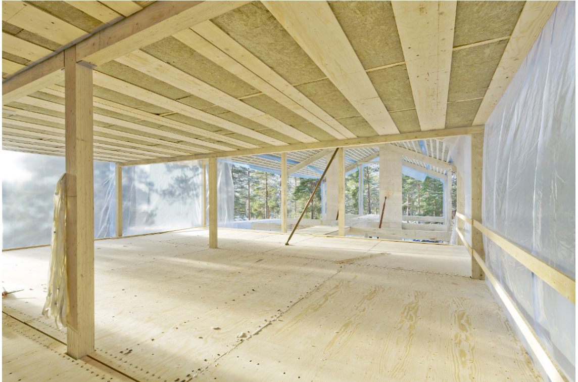
KUVA 12. Metsä Wood -kerrostalojärjestelmää käyttäen rakennettu Piispalan nuorisokeskus pilari-palkki -rungon pystytyksen jälkeen (29).
