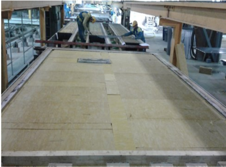
Kuva 5. Eristeet asennettuna elementtiin asennusohjeen mukaisesti.
