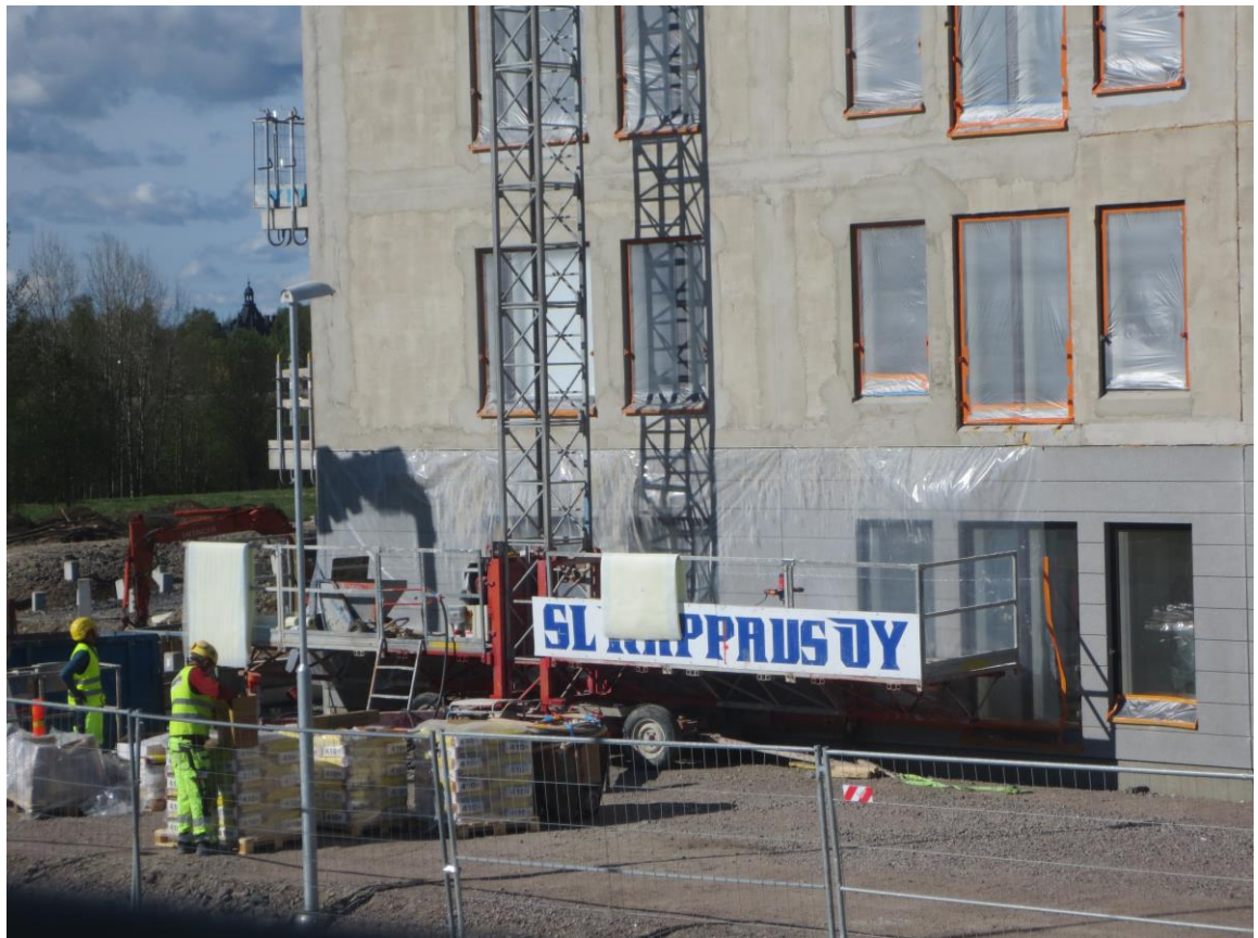
Kuva 19 Julkisivun suojausta rakennemuovilla. (Kuusisto 2016)
