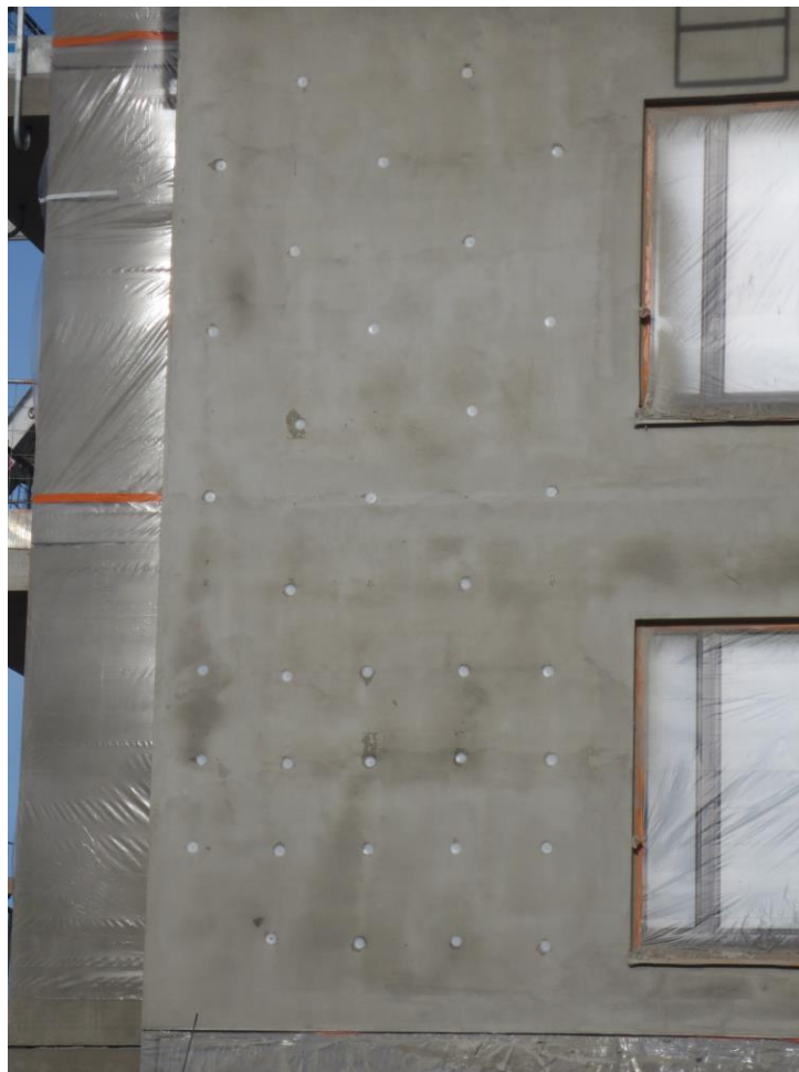
Kuva 18 Mekaaniset kiinnikkeet on asennettu eristeeseen. (Kuusisto 2016)
