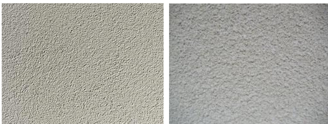
Kuva 22 Vasen puoli on hierrettyä pintaa ja oikealla on roiskepinta. (Rakentaja.fi)
