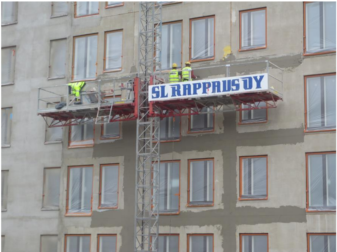
Kuva 25 Elementtisaumojen vahvistamista (Kuusisto 2017)
