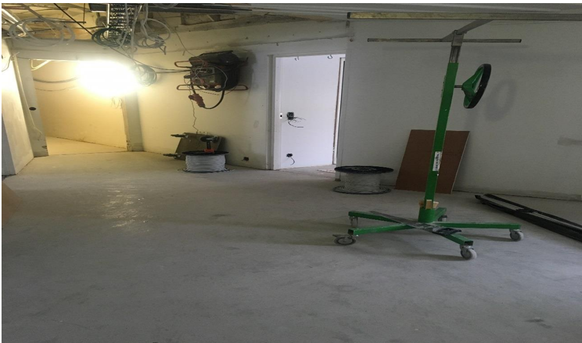
KUVA 1. Työmaan järjestys ja siisteys (Kuvannut Antti Kovalainen)
