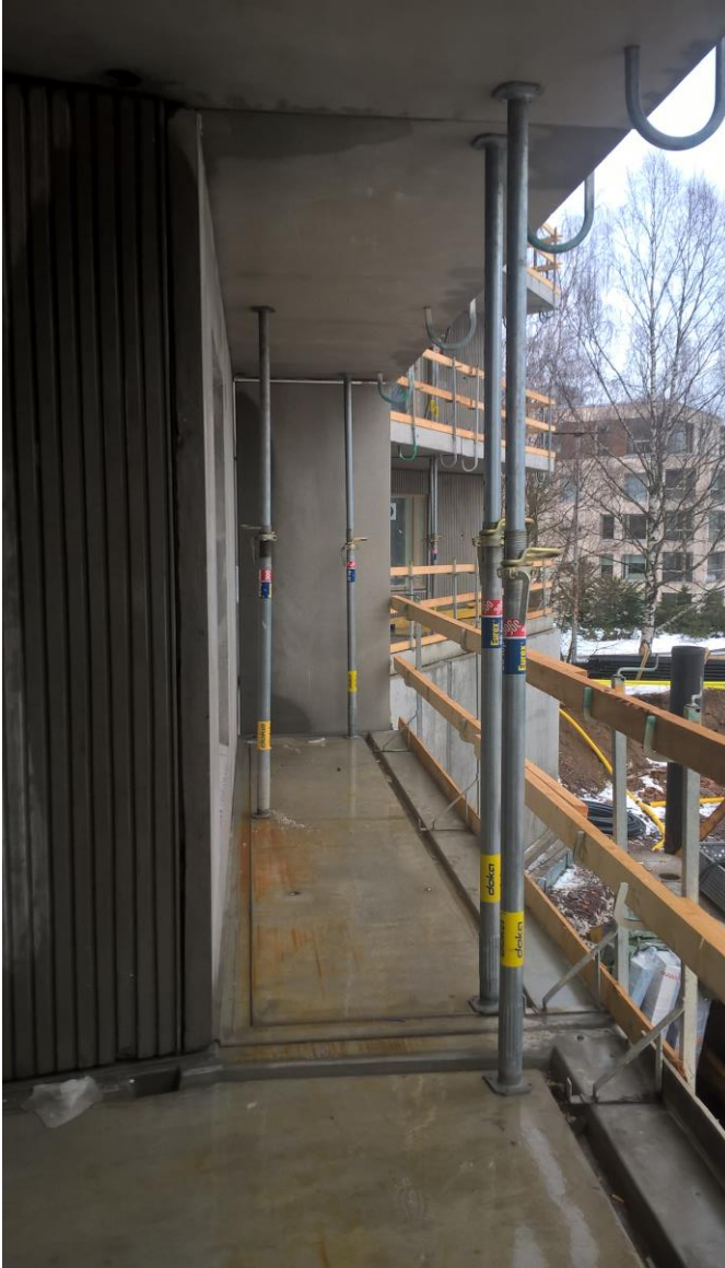
Kuva 19. Ulokeparvekkeen jälkituenta teräksisillä holvituilla.
