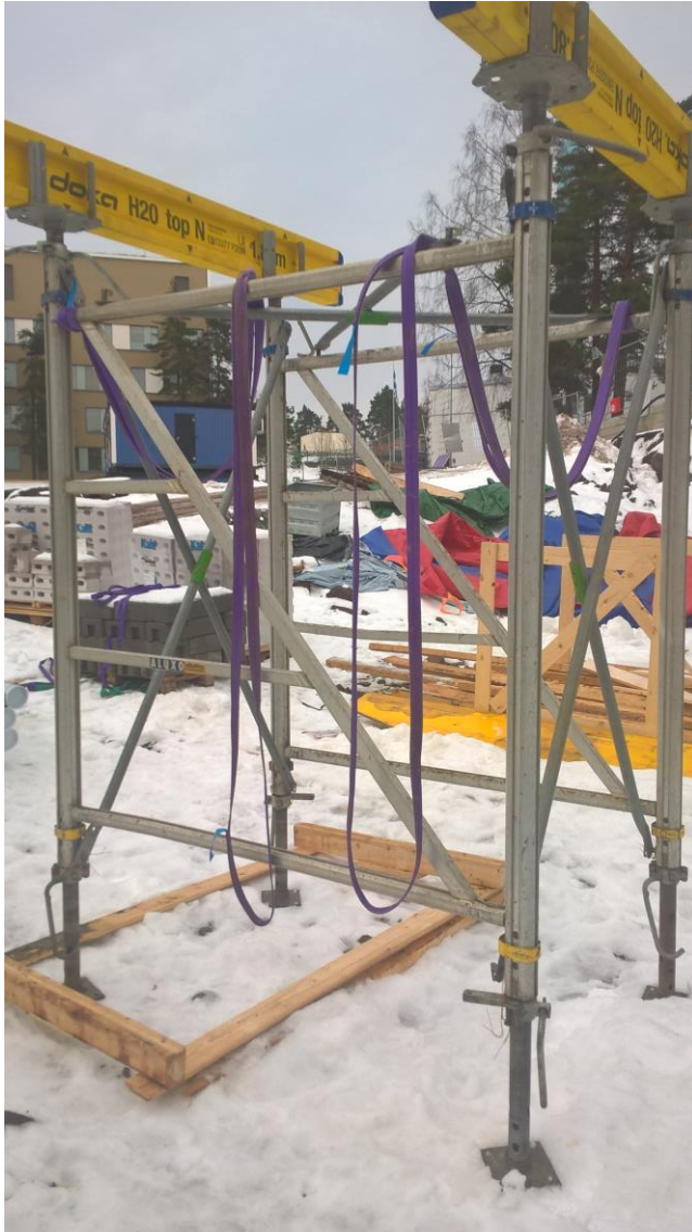
Kuva 15. Esivalmisteisista alumiinikehistä ja ristikoista koottu tukitorni.
