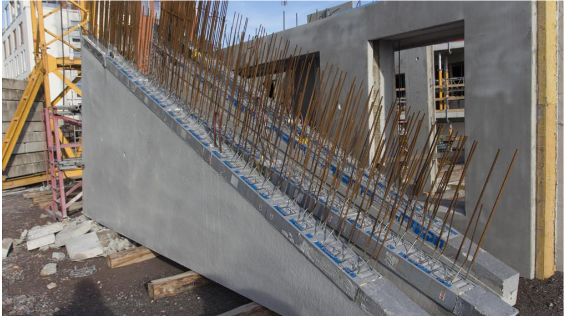
Kuva 11. Parvekelaatta toimitetaan työmaalle liitososat valmiiksi asennettuina [16].
