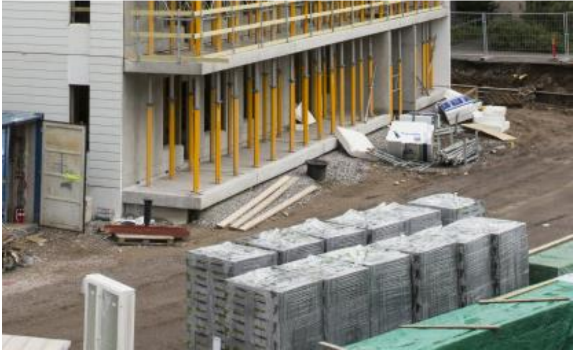
Kuva 20. Ulokeparvekkeen jälkituenta alumiinisilla holvituilla [28].
