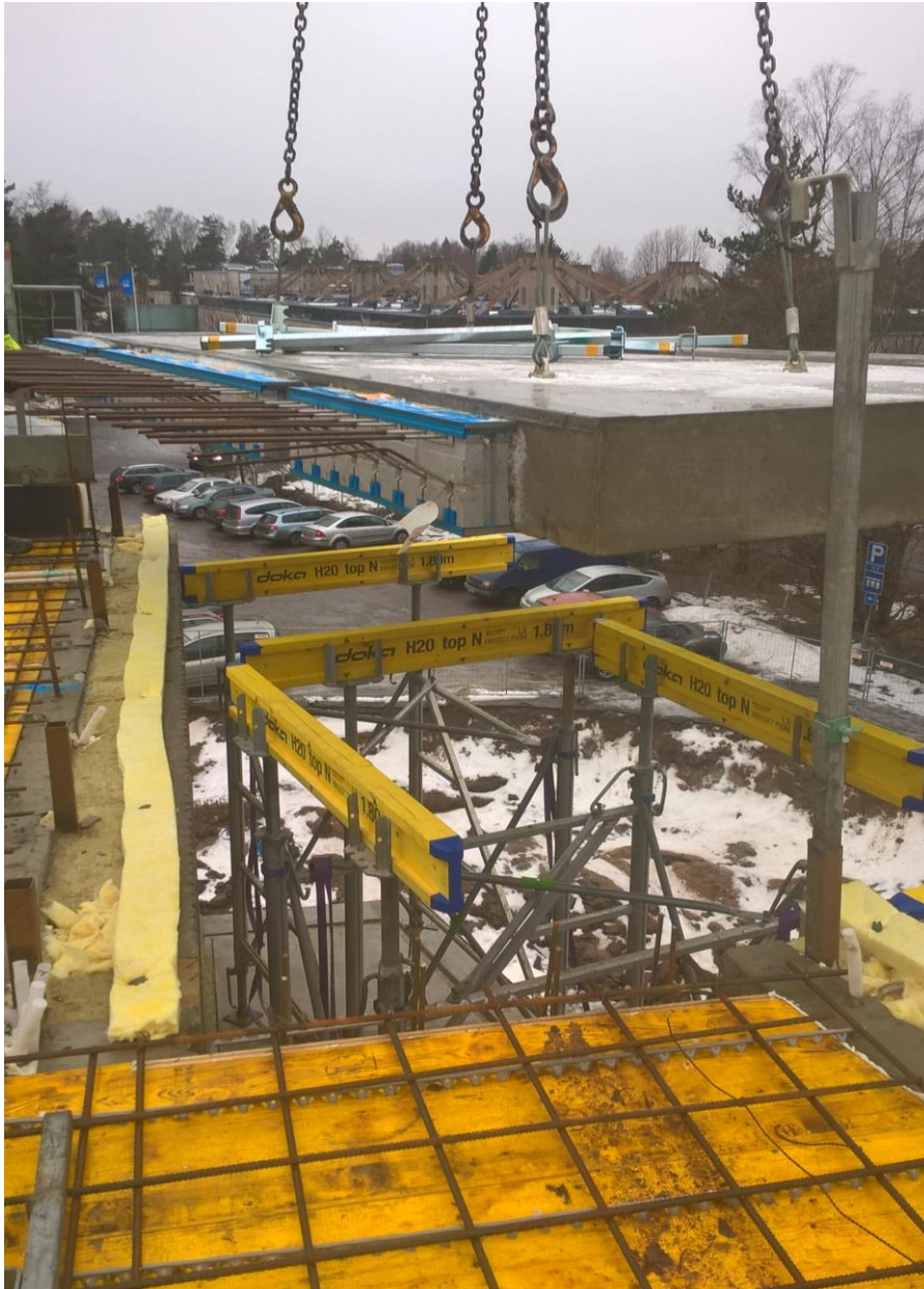
Kuva 14. Parveke-elementin asennus asennusaikaisten tukien varaan ennen välipohjalaatan valua.
