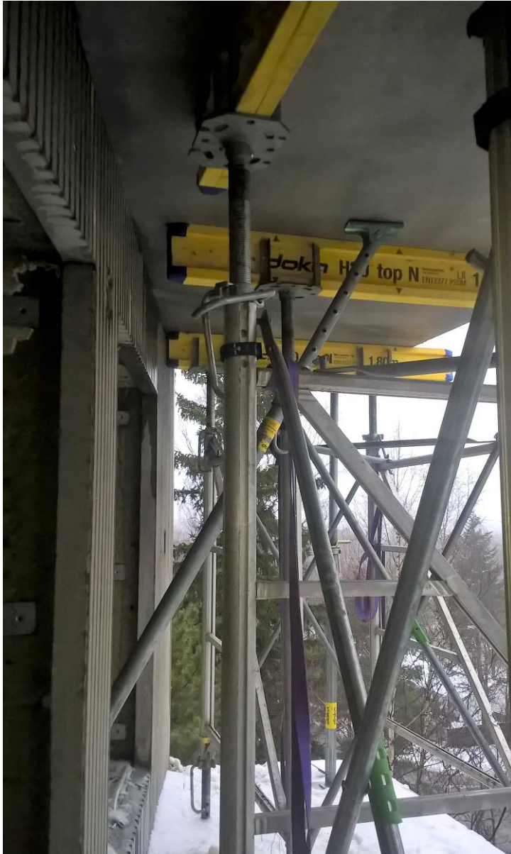
Kuva 17. Parveke-elementti asennettuna asennusaikaisen tuennan varaan ja sidottuna vaakaliikkeitä vastaan elementtituella ikkunapenkistä.
