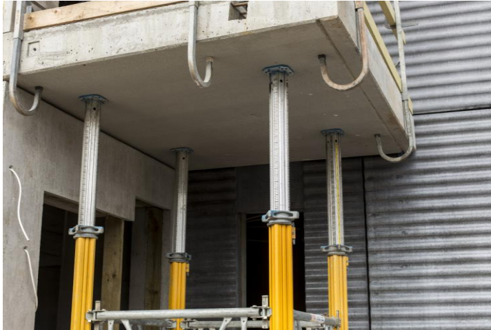
Kuva 16. Alumiinisista holvituista ja ristikkositeistä koottu tukitorni [28].
