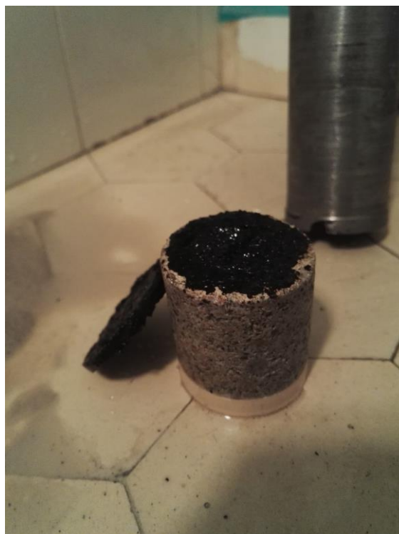
Bild 6. Asbesthaltigt vattenisoleringsbitumenlager i höghus byggt år 1956.
