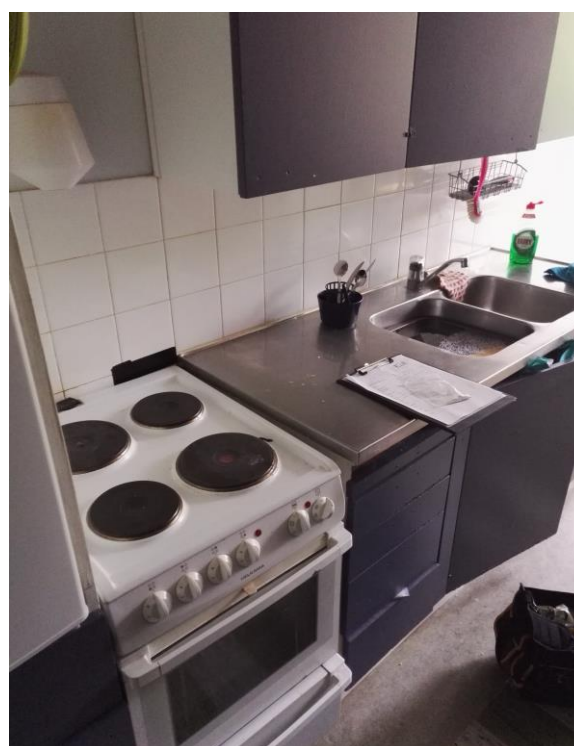
Bild 14. Kök i höghus byggt 1968. Ursprungliga fastsättningsbruket och fogmassan innehåller asbest.
