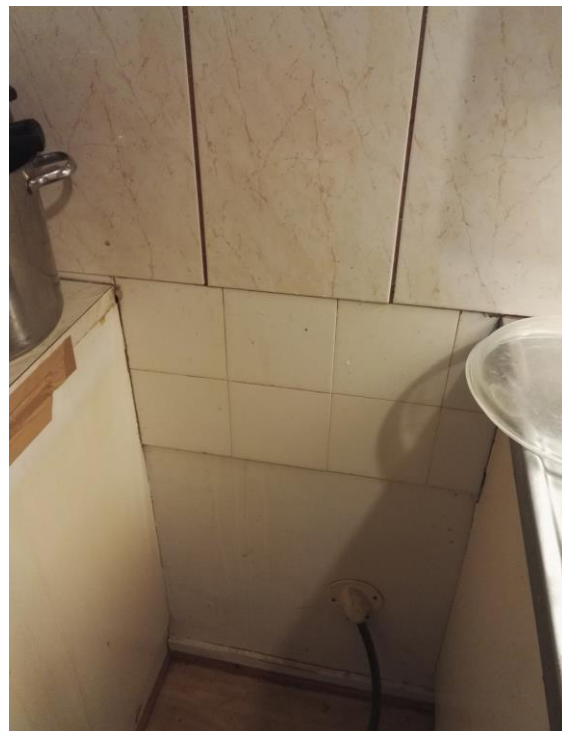
Bild 18. Kök i höghus byggt 1967. Köket har renoverats, men två rader av det ursprungliga kökskaklet med asbesthaltigt fastsättningsbruk har lämnats kvar.
