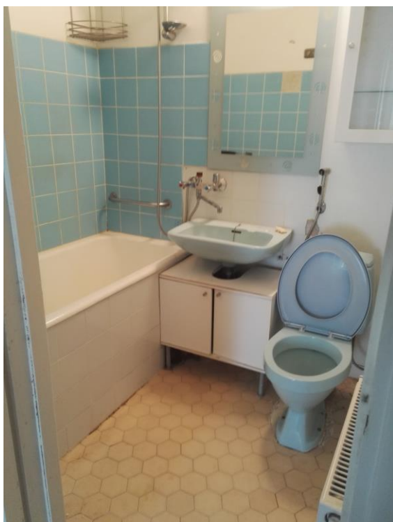
Bild 5. Badrum i höghus byggt 1954. Ursprungliga materialerna innehåller inte asbest men väggkavel med asbesthaltigt bruk har lagts till på 1970-talet
