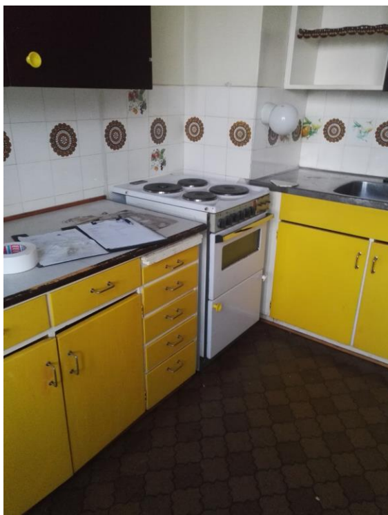
Bild 13. Kök i höghus byggt 1957. Ursprungliga fastsättningsbruket innehåller inte asbest.
