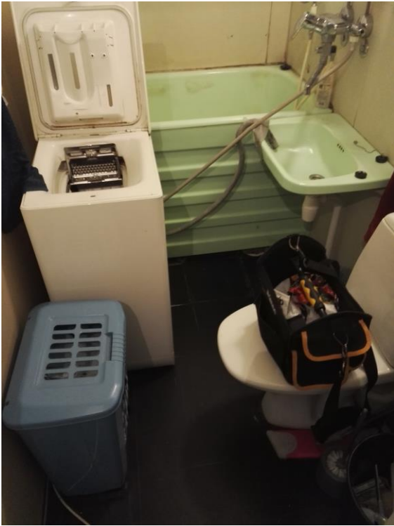
Bild 7. Badrum i höghus byggt 1964. Ursprungliga golvmaterialet är vinylplattor fastlimmade med asbesthaltigt bitumenlim.
