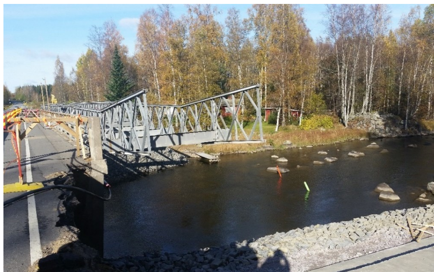
Kuva 6. Universal-varasillan lanseeraus loppuvaiheessa (Destia Oy 2016).
