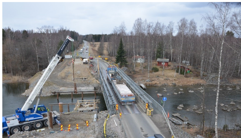
Kuva 1. Väliaikainen silta käytössä valtatie 12:lla. (Ternola 2017.)
