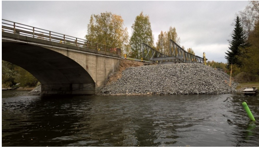
Kuva 5. Universal -varasillan rakennusvaihe käynnissä. (Ternola 2016)
