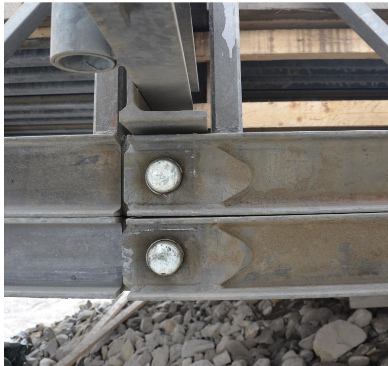
Kuva 3. Kehäristikoiden välinen tappikiinnitys. (Ternola 2017.)
