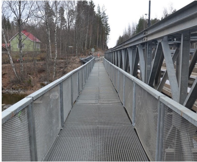
Kuva 4. Universal-varasillan yhteyteen rakennettu kevyenliikenteenväylä. (Ternola 2017)
