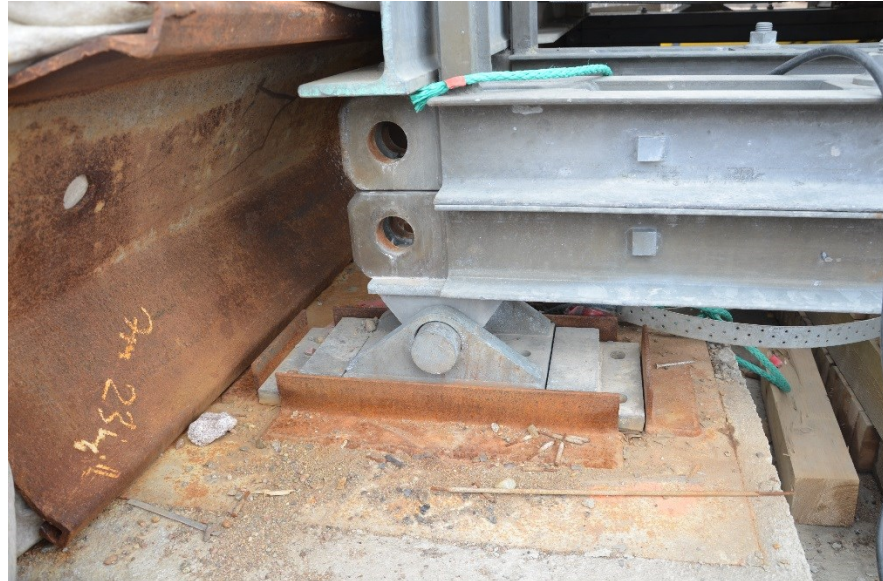
Kuva 7. Universal-kalustoon kuuluva kiinteä laakeri. Vasemmalla tukimuurina toimiva Larssen 603 -teräsprofiililevy. (Ternola 2017)
