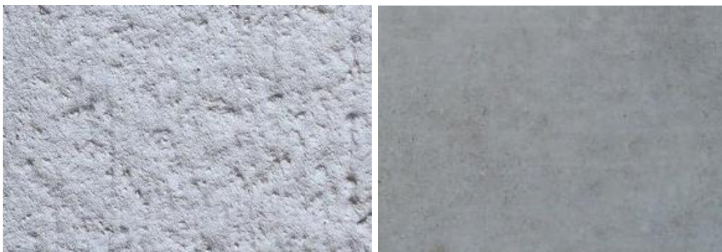
KUVA5. Vasemmalla puolella on telattu pinta ja oikealla puolella teräshierretty pinta. (10, s.6)
