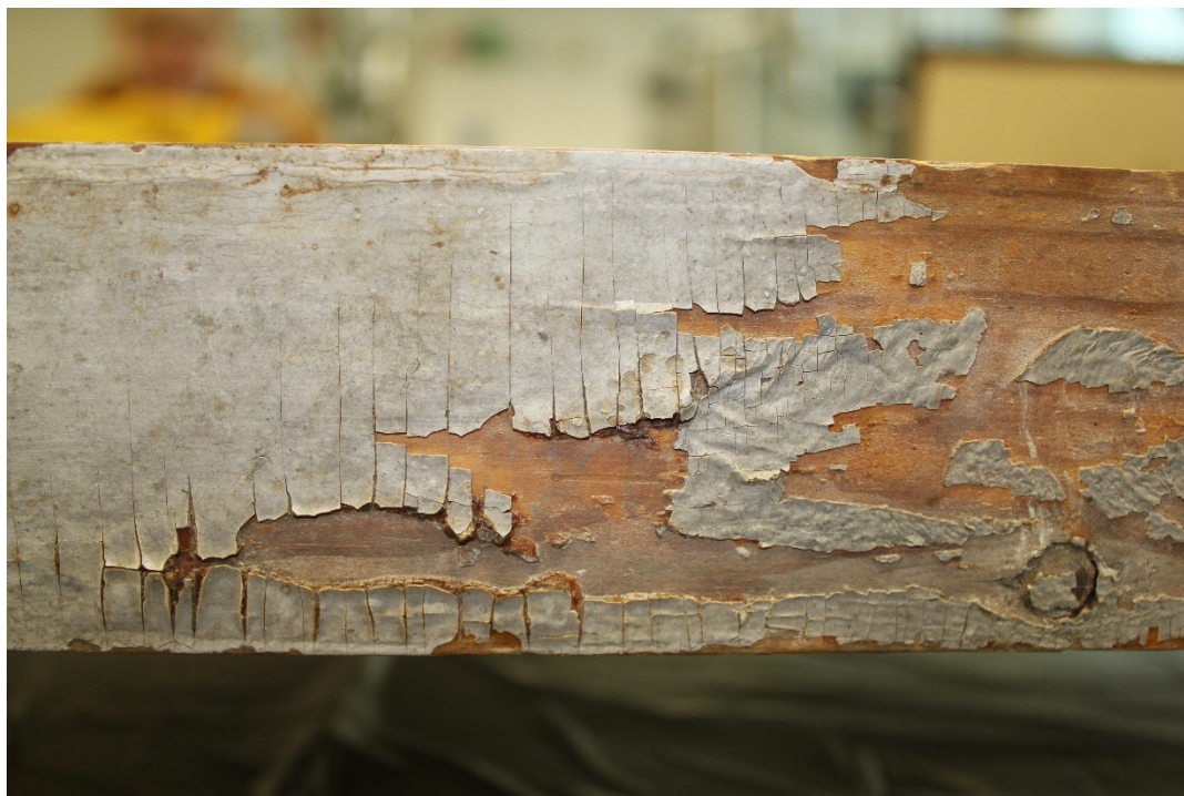
Kuva 13. Oikean sivun alaosan vaurioitunut maalipinta (Hyvönen 2017)
