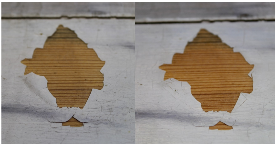
Kuva 24. Vasemmalla maalipinta ennen kiinnitystä ja puhdistusta. Oikealla maalipinta kiinnityksen ja puhdistuksen jälkeen (Hyvönen 2017)
