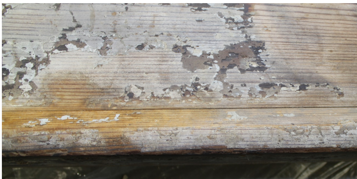
Kuva 25. Reunan puhdistettu puupinta vasemmalla, puhdistamaton oikealla (Hyvönen 2017)
