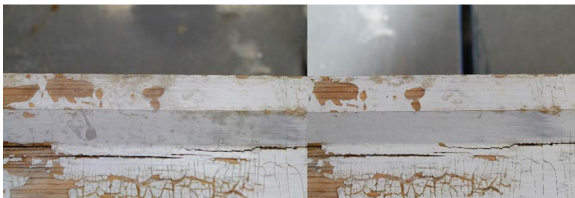
Kuva 26. Etupuolen profiilista vasemmalla ennen puhdistusta ja oikealla puhdistuksen jälkeen (Hyvönen 2017)
