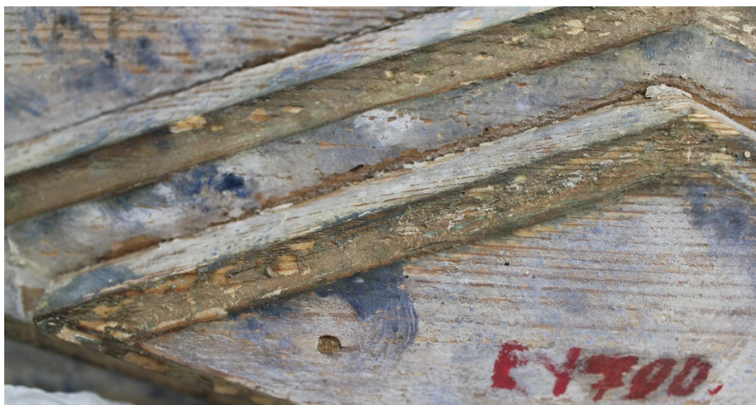
Kuva 30. Yläprofiilin koristeuran maalipinta maalinkiinnityksen ja puhdistuksen jälkeen (Hyvönen 2017)
