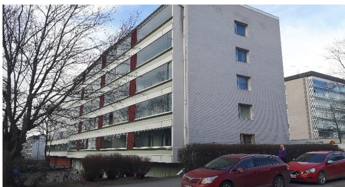
Figur 2. Skolhusgatan 13 fasaden mot söder
