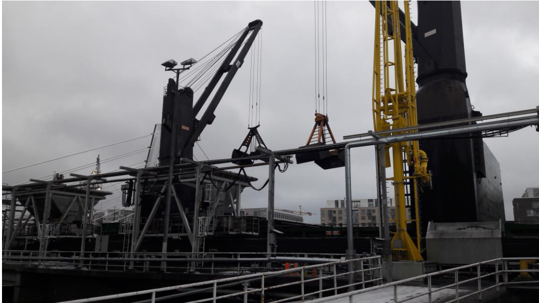
Kuva 2. Hiilenpurku syöttimeen Tammasaaren satamassa 2017.
