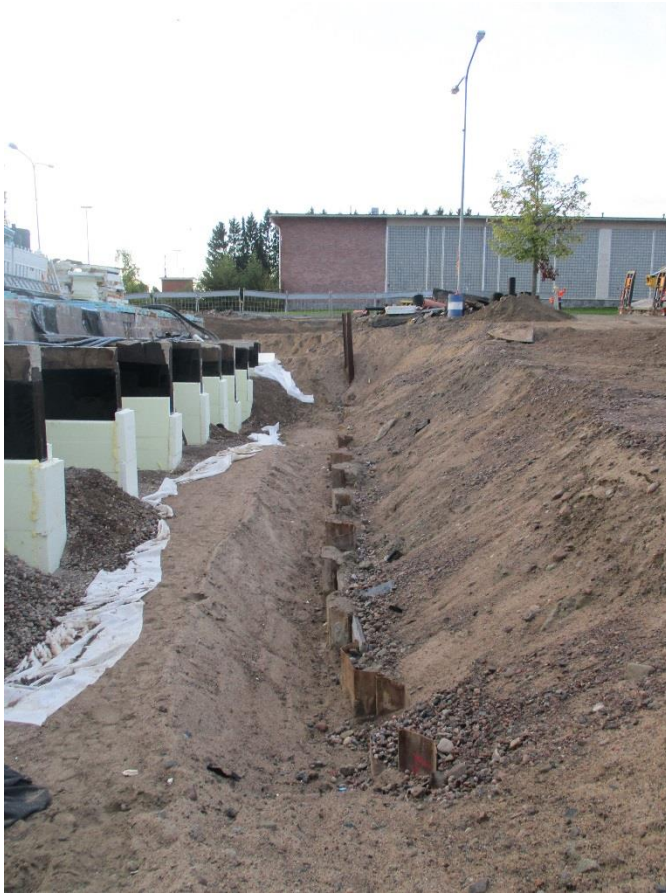
Kuvio 12. Teräsponnit kaivettu näkyviin poistoa varten.
