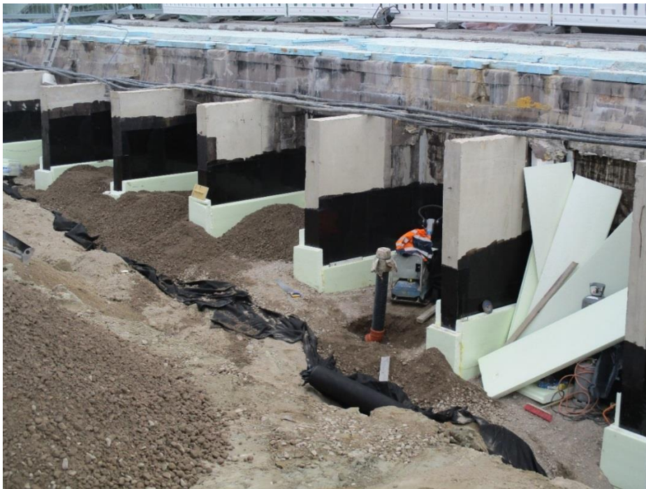
Kuvio 2. Kaapelien tuenta maanpaineseinän ulokkeiden päälle.
