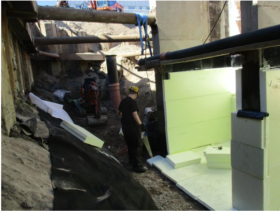
Kuvio 14. Routaeriste maanpaineseinän ja anturan suojana.
