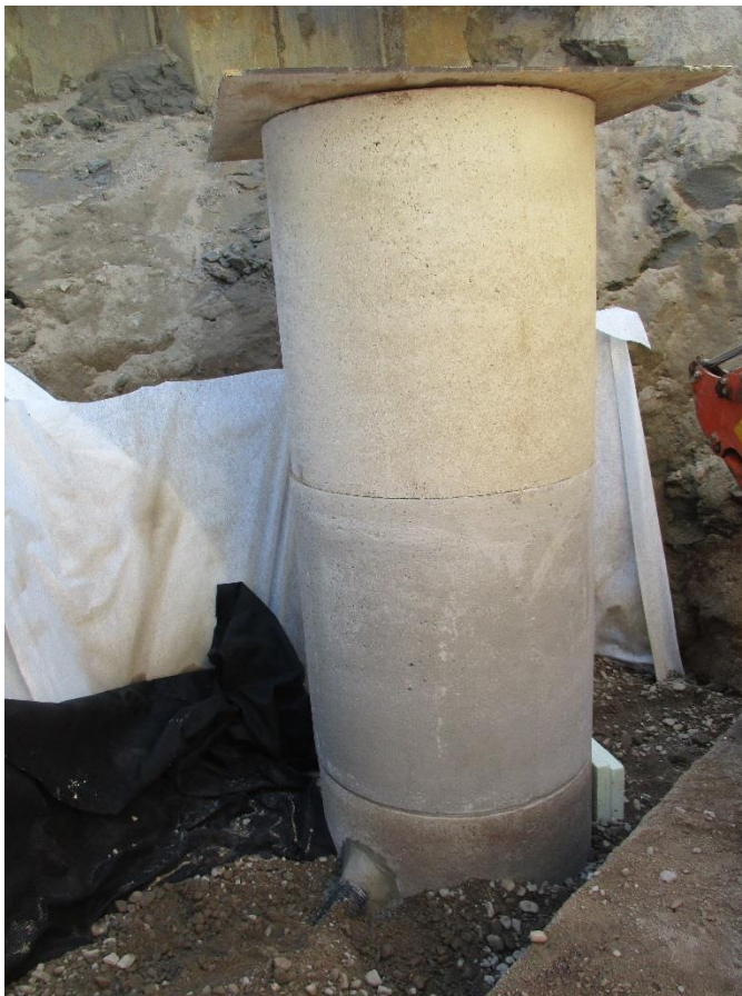
Kuvio 15. Betonirenkain toteutettu salaojakaivo.
