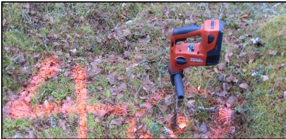
Kuva 18. Aurauskeppien reiät tehtiin poralla. Keskipisteet merkittiin numerojärjestyksessä, jotta merkattaessa kaikki huomattiin. (Väyrynen 2017).
