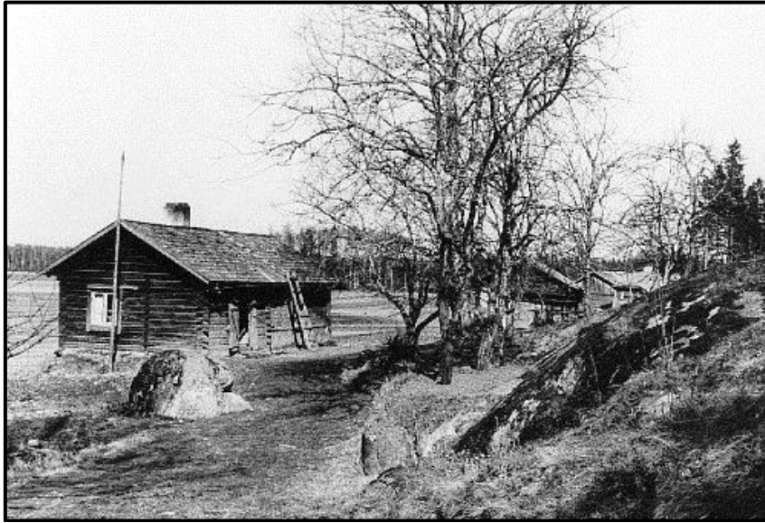
Kuva 3. Torppa Keimolassa. Torppia perustamalla pyrittiin helpottamaan tilattomuutta (Helsinki n.d.).
