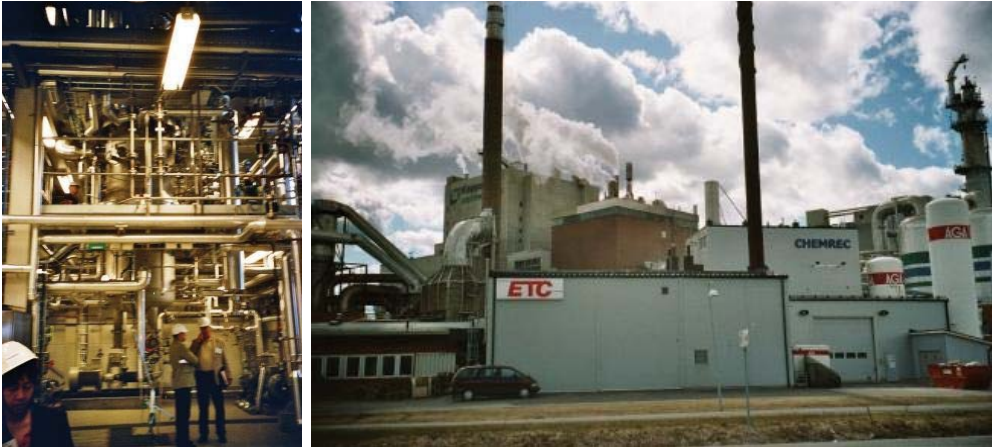
Kuva 5.22. Mustalipeästä DME:tä ja metanolia valmistava Chemrecin 3 MW:n demonstraatiolaitos Kappan sellutehtaan yhteydessä Piteässä Ruotsissa. [2005]
