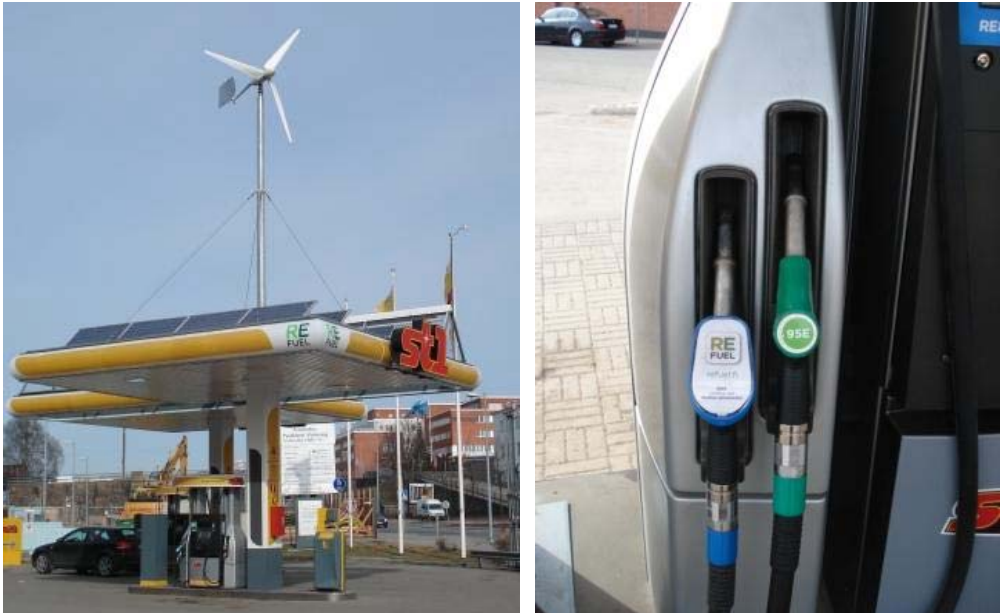
Kuva 6.3. St1 aloitti 1.4.2009 jäteperäisen E85:n myynnin REfuel-tuotemerkillä kolmella pääkaupunkiseudun asemallaan. Kuvassa on Vallilan asema, joka on Viitasaaren ABC:n jälkeen Suomen toinen huoltoasema, joka tuottaa sähköä tuuliturbiinilla ja aurinkopaneeleilla. Sähkö on aseman omaan käyttöön; sähköautolatauspistettä ei ole. [2009]
