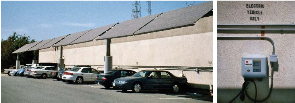
Kuva 2.90. a) Sacramento'n kunnallisen sähköyhtiön (SMUD) pääkonttorin pihassa oleva katettu parkkialue, jonka päällä olevia aurinkopaneeleita käytetään sähköautojen pysäköinnin aikaiseen aurinkosähkölataukseen ja samalla aurinko- ja sadesuojana. Sähköautojen omistajilla on tyypillisesti SMUDin toimittama aurinkolatausjärjestelmä myös kotonaan. b) Latauksen kontrollilyksikkö. [2004]
