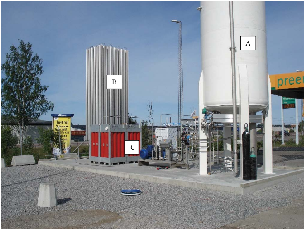
Kuva 3.27. AGA:n LCBG-tankkausasema rakenteilla Sundsvallissa Ruotsissa Preemin bensa-ase- man yhteyteen. LBG pumpataan korkeasta varastotankista (A) höyrytimen (B) kautta punaisiin CBG-välivarastopulloihin (C), josta kaasu saadaan autoihin Preemin tankkauspistoolin kautta. [2009]
