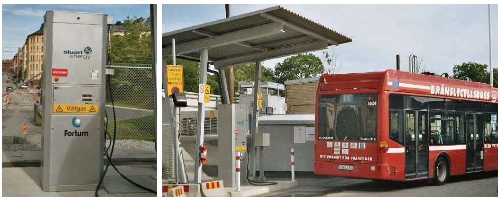
Kuva 5.26. Stuart Energy:n elektrolyysi- ja vetytankkauslaitteisto, jonka avulla tuotetaan vesi-, tuuli- ja biosähköllä vetyä MB Citaro -polttokennobusseihin Tukholmassa. [2005]
