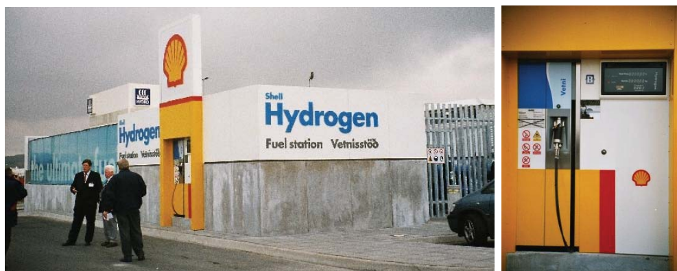
Kuva 3.23. Maailman ensimmäisen huoltoasemaketjun tavanomaisella lämminasemalla olevan vetytankkauspisteen avajaiset vuonna 2003 Reykjavikissa. Vety tuotetaan asemalla vesijohtovedestä elektrolyysillä geotermisen ja vesivoiman avulla. [2003]
