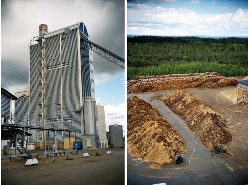
Kuva 5.21. Puuta käyttävä 18 MW:n kaasutus- ja metanoli/DME-synteesilaitos Värnamossa Ruotsissa. [2006]
