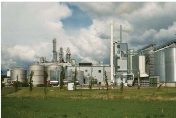
Kuva 5.5. Agroetanol-yhtiön viljaperäisen liikenne-etanolin tuotantolaitos Norrköpingissä Ruotsissa. Vuosituotanto on 210 miljoonaa litraa. Sivutuotteena saadaan 175.000 tonnia proteiinirikasta rehua, jolla korvataan ulkomaisen soijarehun tuontia. [2006]
