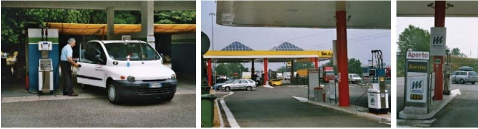
Kuva 2.128. Maakaasun tankkausasemia Italiassa: a) taksi (Fiat Multipla Bipower bifuel-auto) tankkaamassa 1970-luvun alussa Milanon lentokentällä avatulla maakaasuasemalla, b-c) moderni aurinkopaneelilla sähköistetty huoltoasema Pisan lähellä Pohjois-Italiassa. [2004]
