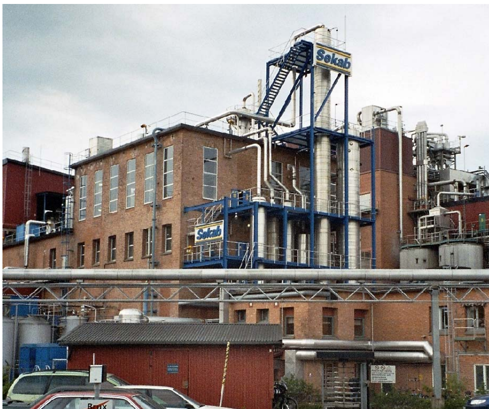
Kuva 5.33. Sekabin tehdas, joka valmistaa etanolia sulfittisellutehtaan jätevedestä ja hakkeesta Modon sulfittisellutehtaan yhteydessä Örnsköldsvikissä Ruotsissa. [2005]
