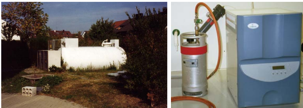
Kuva 5.25. a) Aurinkovetyjärjestelmän avulla energiaomavaraisen talon vetyvarasto Freiburgissa Saksassa. [1996] b) Kotimainen Labgasin omakotitalokokoluokan PEM-elektrolyysilaitteisto vedyn valmistamiseksi vedestä (oikealla) sekä kotimainen Hydrocellin vedyn varastointisäiliö (vasemmalla). Tällä laitteistolla valmistetaan paikallisella tuuli- ja aurinkosähköllä vetyä kotimaiseen e3:n Fantasia-polttokennoautoon Jyväskylän yliopistossa. [2005]
