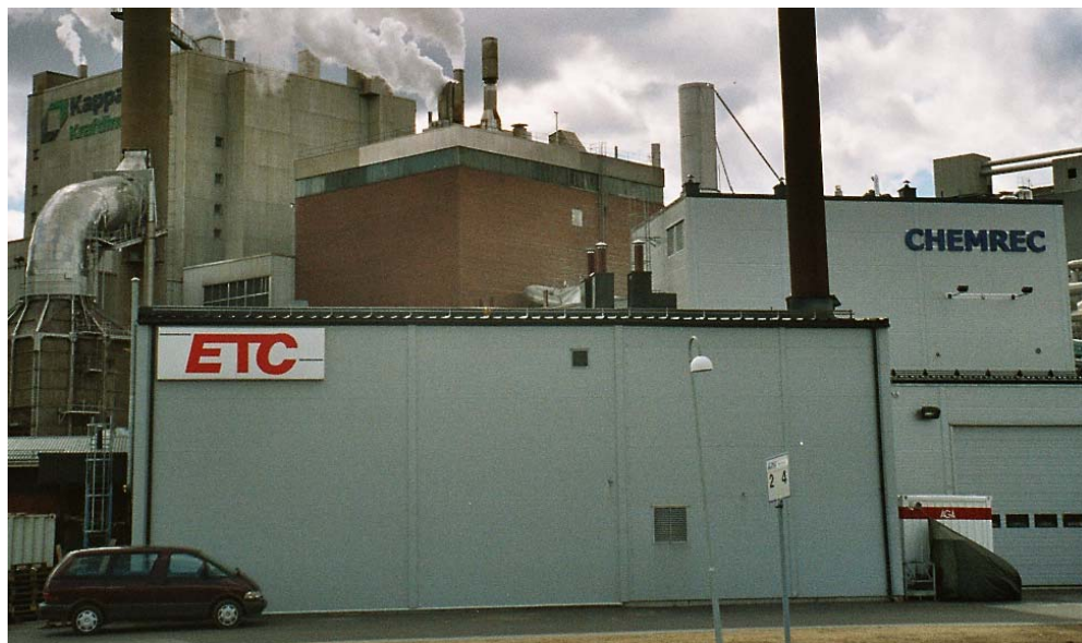
Kuva 5.32. Chemrecin mustalipeän kaasutukseen perustuva synteettisten liikennepolttoaineiden tuotannon 3 MW:n demonstraatiolaitos Kappan sulfaattisellutehtaan yhteydessä Piteässä Ruotsissa. [2005]
