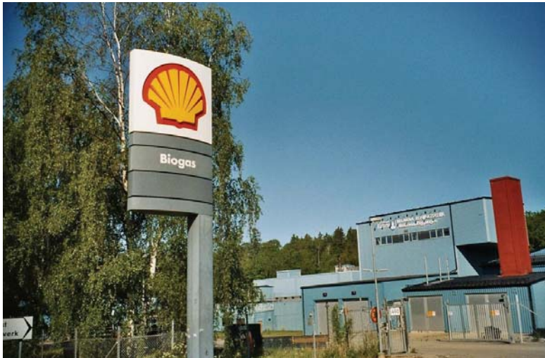
Kuva 5.7. Bromman jätevedenpuhdistamolla Tukholmassa on vuodesta 1996 lähtien valmistettu liikennebiokaasua kaupunkilaisten ulosteista ja virtsasta. Sitä myydään monen huoltoasemaketjun jakeluasemilla Tukholman alueella, mm. jätevedenpuhdistamon vieressä. [2005]
