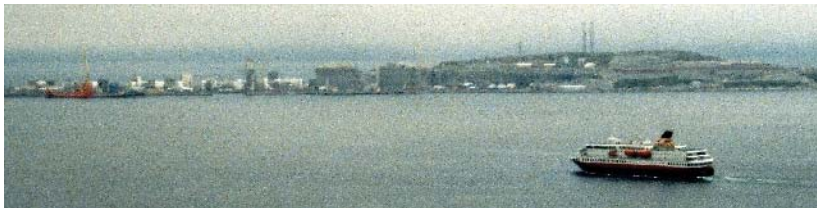
Kuva 2.12. Norjan rannikkoa pitkin kulkeva Hurtigruten-risteilijä Hammerfestin edustalla. Taustalla on Statoilin rakenteilla oleva Norjan ensimmäinen maakaasun nesteytyslaitos ja LNG-satama, johon maakaasu kuljetetaan merenpohjaa pitkin kulkevilla putkilla 160 km päästä Snøhvit-kentältä Jäämereltä. Suurin osa hiilidioksidista erotetaan tässä laitoksessa maakaasusta ja kuljetetaan takaisin toisilla putkilla syötettäväksi Snøhvit-kentän maakaasulähteisiin. [2005]
