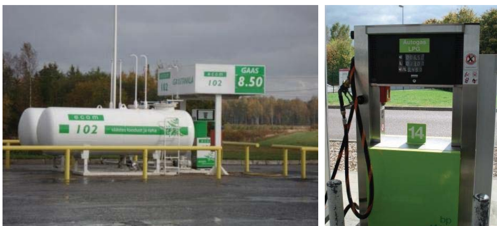
Kuva 2.123. Nestekaasun tankkausasema Eestissä (a) ja Luxemburgissa (b). Suomessa yleisiä ajoneuvoille tarkoitettuja nestekaasun tankkausasemia ei ole. [2007]
