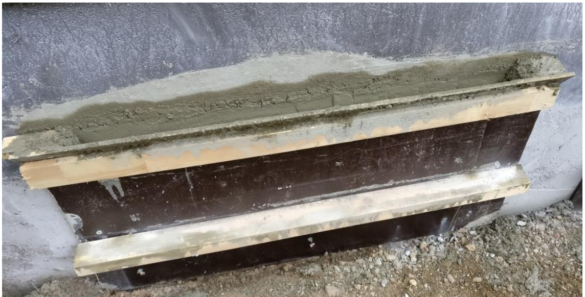
Kuva 14. Valumuotin yläreunasta poistetaan ylimääräinen betoni
