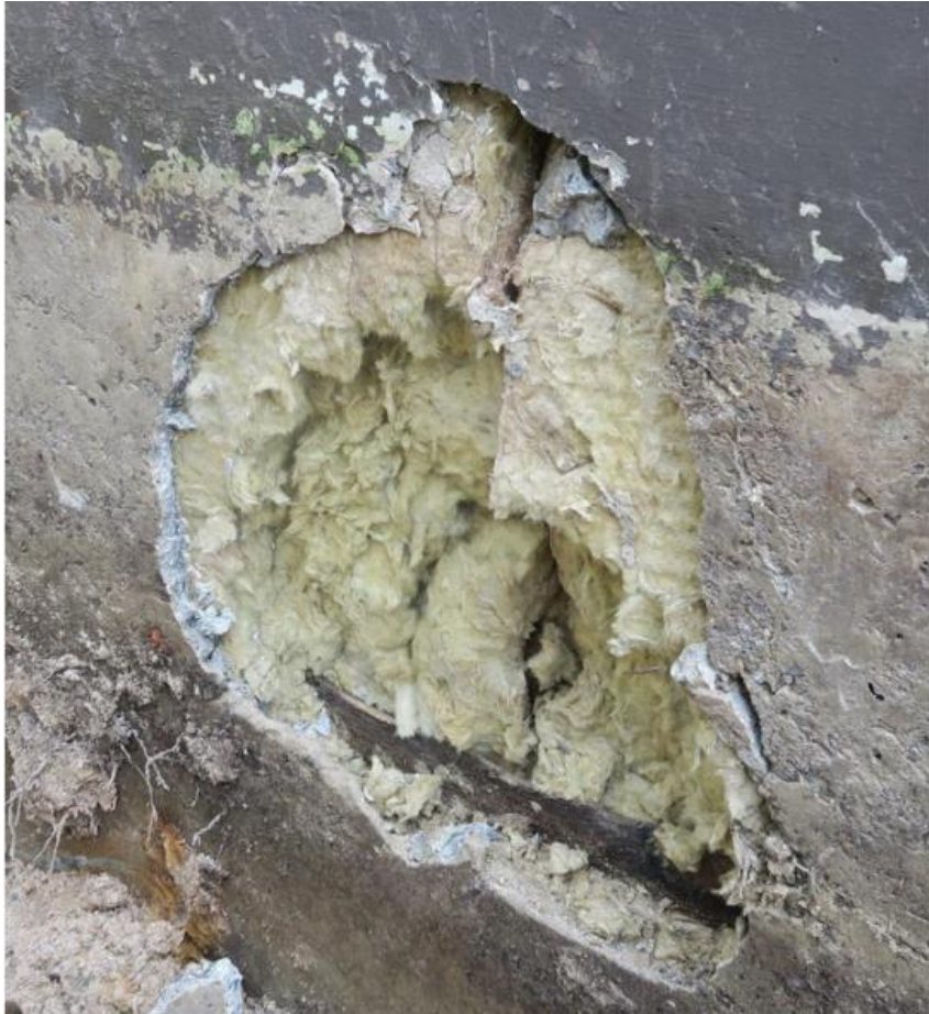
Kuva 4. Sokkelin ulkokuoren paksuus ohuimmassa kohdassa on vain 10mm (Heikkinen. 2016.)
