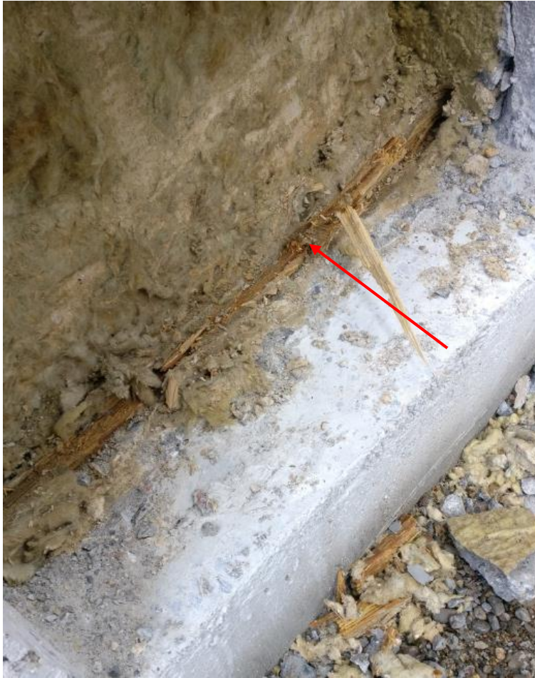
Kuva 11. Sokkelihalkaisussa esiintyvä puujäte
