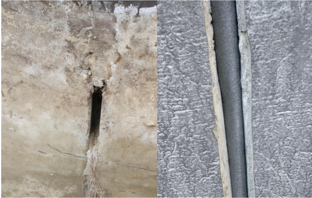
Kuva 15. Vanha ja uusi sokkelielementin liikuntasauga
