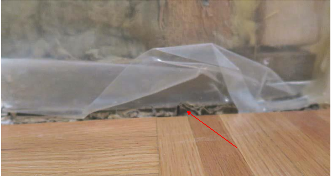
Kuva 3. Ulkoseinän ja lattia välinen höyrynsulku liitos (Heikkinen. 2016.)
