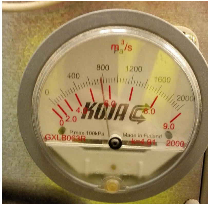
Kuvio 35. Koja-tuloilmapuhaltimen ilmapvirtauksen paikallismittari
