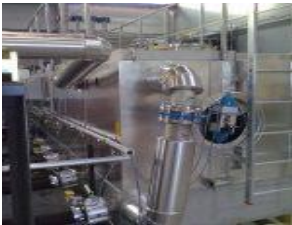
Kuvio 47. Esimerkki öljylämmittimen eristyskoteloinnista
