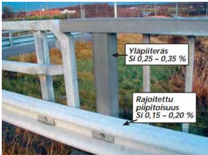
Kuva 8. 15 vuotta käytössä olleet siltarakenteet. [8.]
