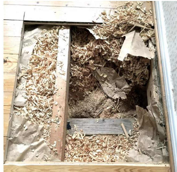
Lattiaeristeitä: sahanpurua ja kutterilastuja pinkopahvin ja lattialaudoituksen alla.
