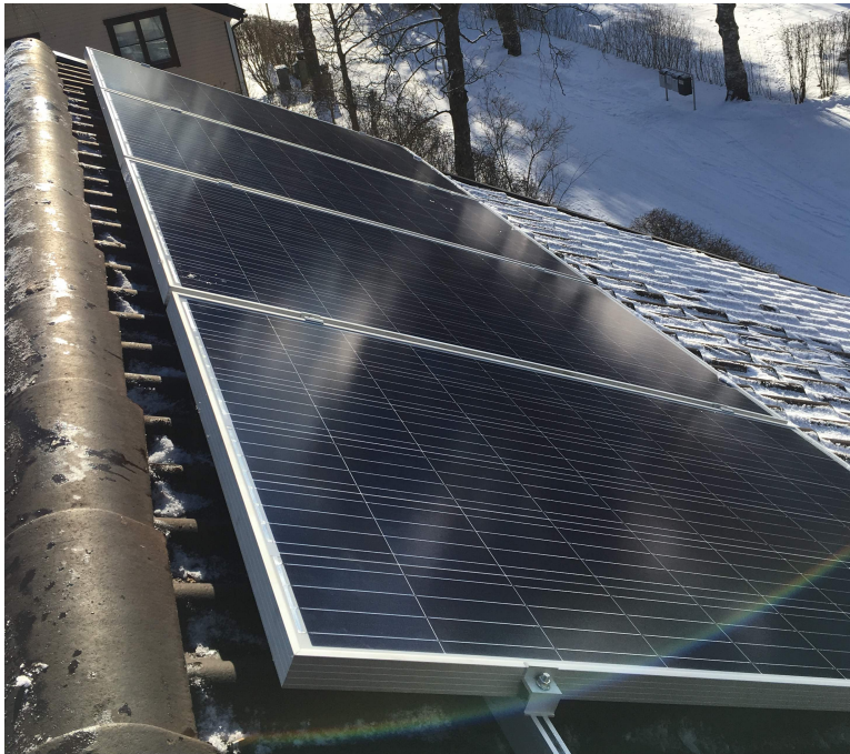
KUVA 18. Aurinkopaneelit asennettuna paikoillaan katolla
