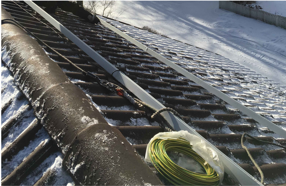
KUVA 16. Aurinkopaneelien asennuskiskot paikoillaan
