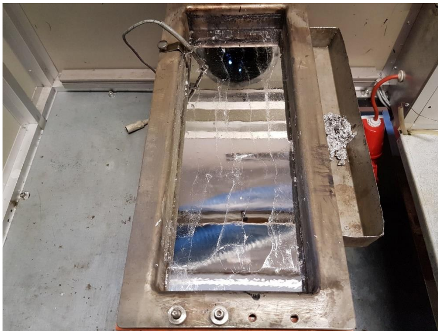
Kuva 4. Tinapata huollon jälkeen.
