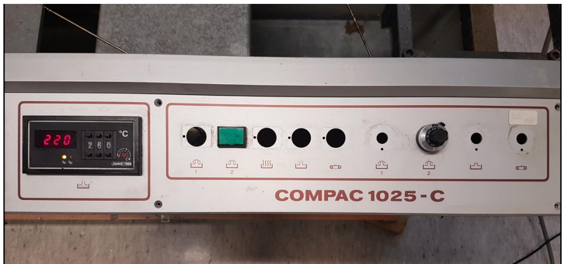
Kuva 25. Ohjauspaneeli sähkölaitteiden poiston jälkeen.
