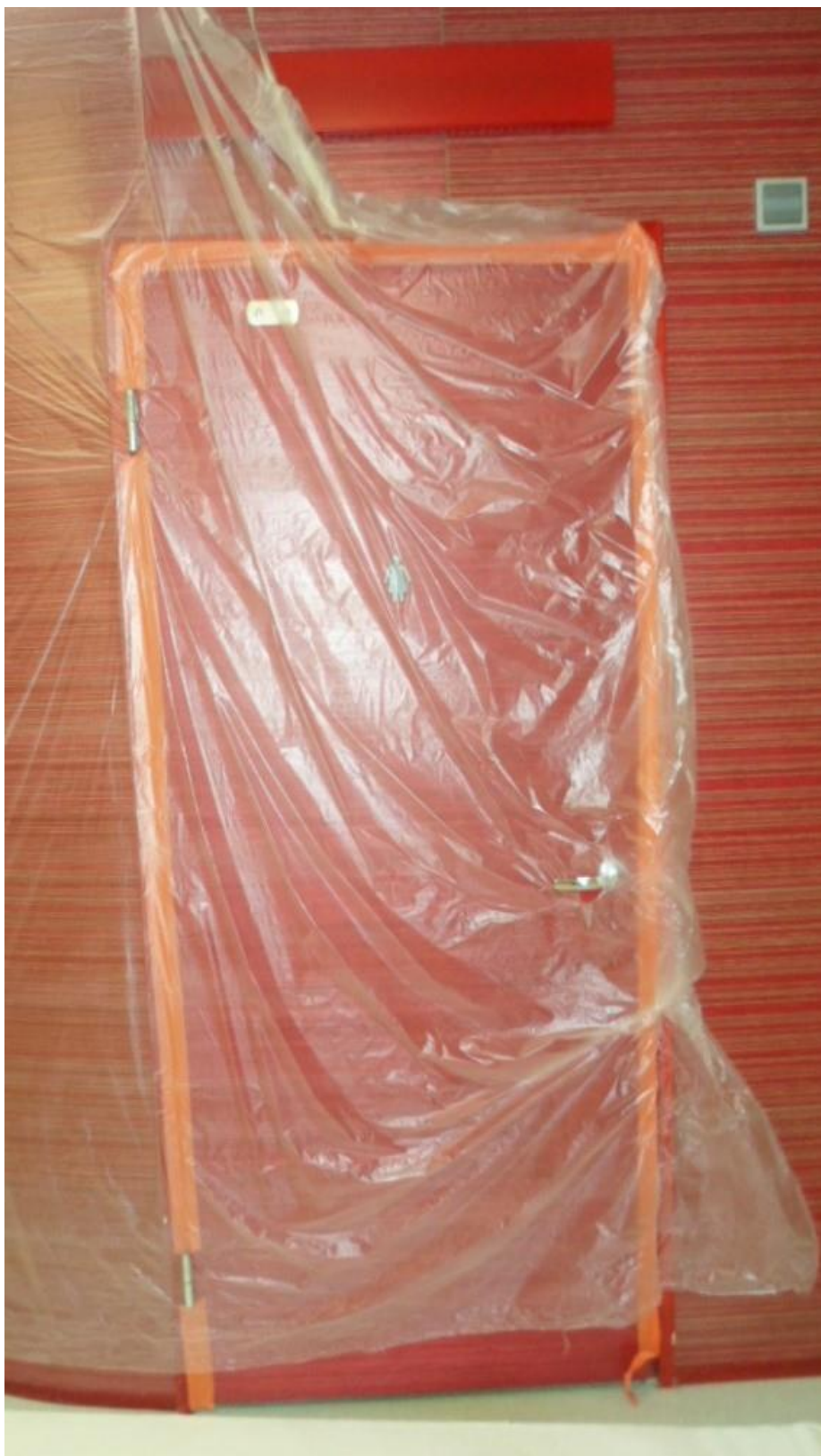
KUVA 2. Pölyhallinnan keinoja toimivien tilojen rajalla (Lappeteläinen 2016)
