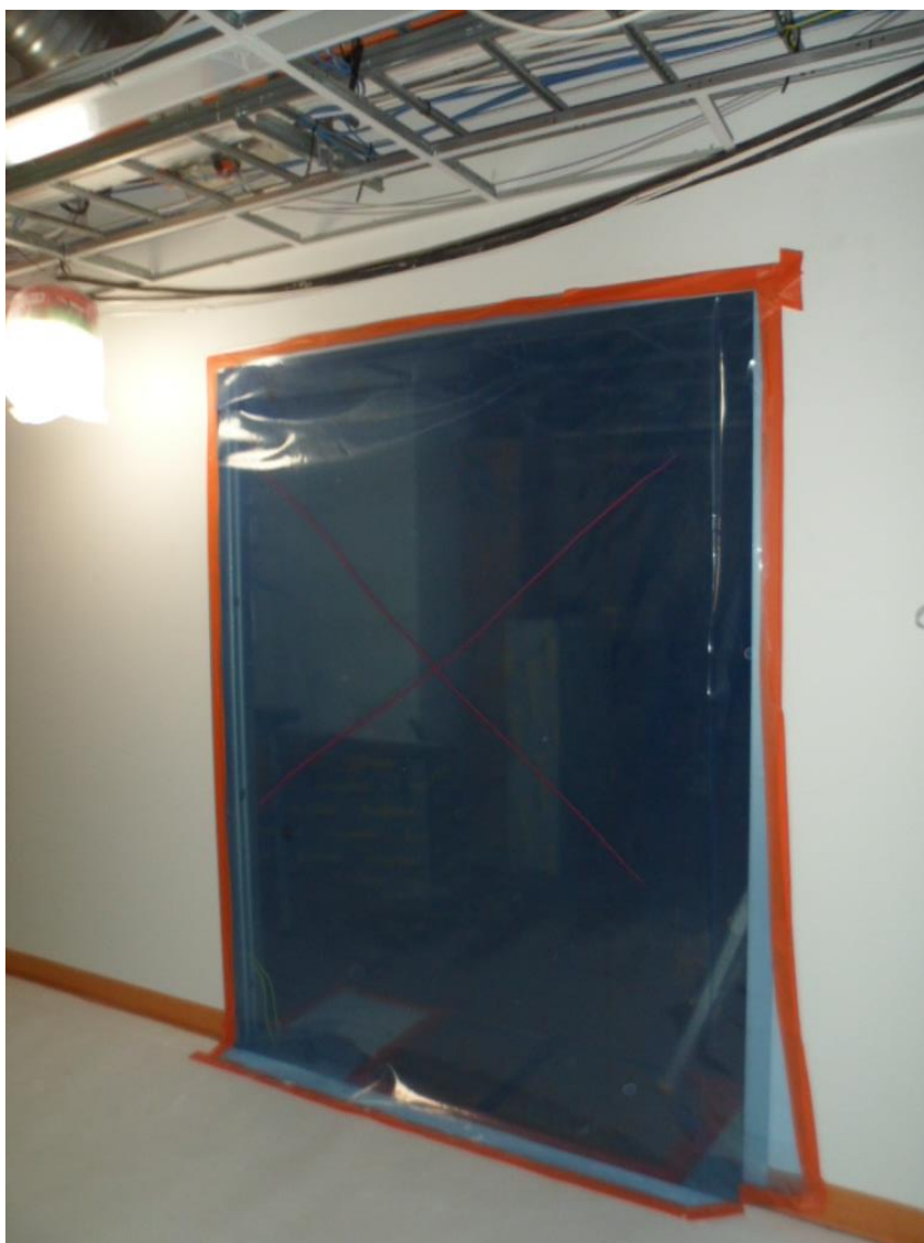
KUVA 3. Osastoitutilla (Lappeteläinen 2016)
