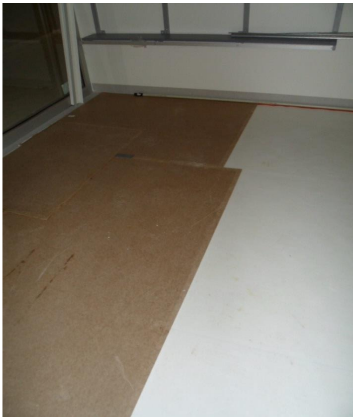
KUVA 4. Rakentamisen aikaiset suojapahvit ja kovalevyt (Lappeteläinen 2016)
