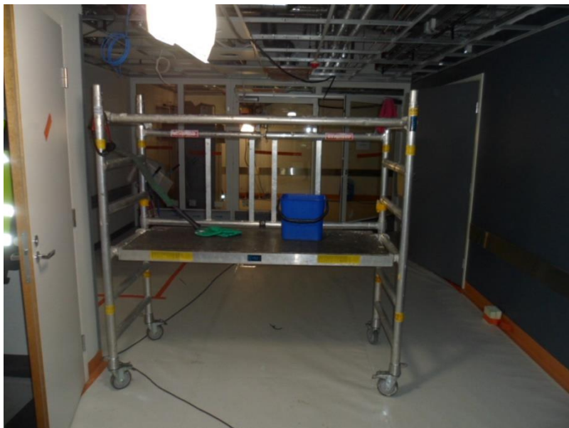
KUVA 7. Loppusiivouksen 1. vaiheessa käytettävä teline ja pesuvälineet (Lappeteläinen 2016)
