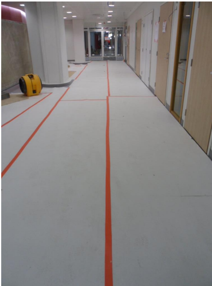
KUVA 5. Rakentamisen aikaista lattia suojausta (Lappeteläinen 2016)
