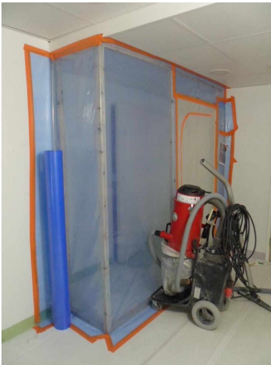
KUVA 6. Osastoitu työtila ja rakennus- tai teollisuusimuri (Lappeteläinen 2016)
