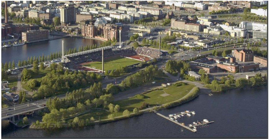
Kuva 14. Ratinanranta ennen rakentamisen aloittamista( http://kuntatekniikka.fi/wp-content )
