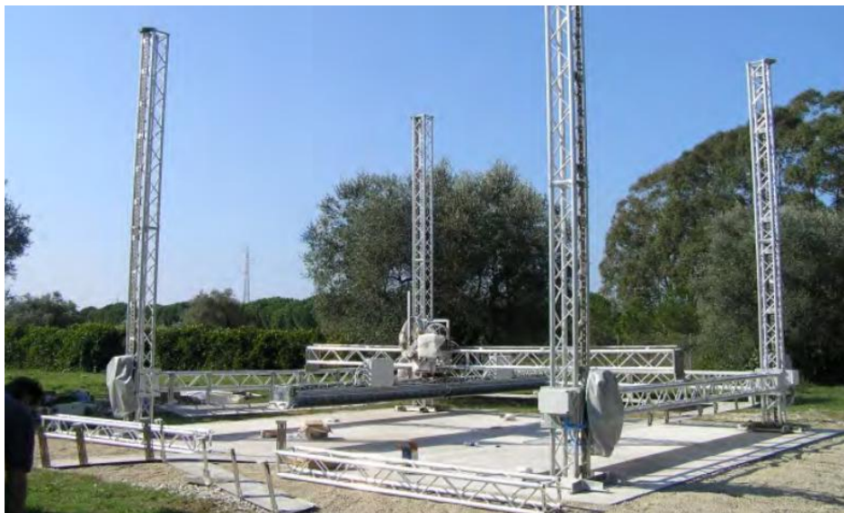
Bild 7 3D-skrivare används för att skriva ut ett hus (Next Nature, 2013)
