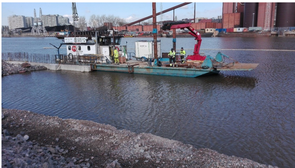
Kuva 12. Sabluuna on seinäelementin levyinen. Elementtien asennus käy nopeammin.
