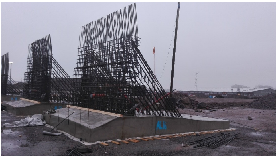
Kuva 6. Elementin loppuosa raudoitetaan pohja-osan valun jälkeen.
