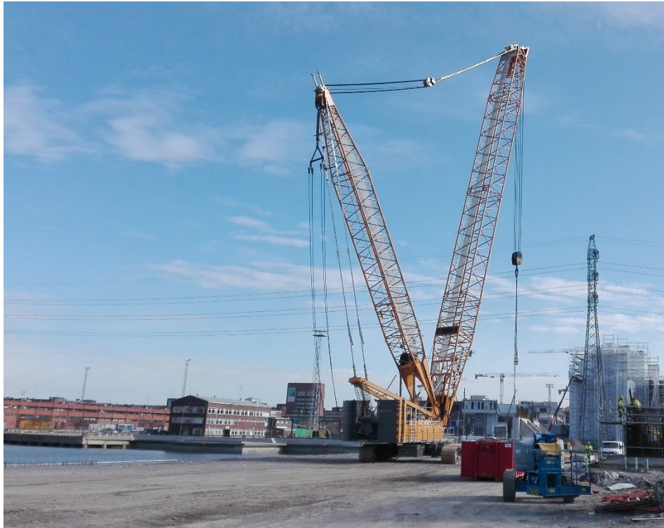
Kuva 11. Nostotöissä käytettävä nostolaite on Liebherrin LR 1300.
