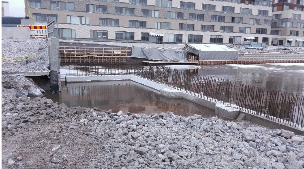
Kuva 14. Elementtejä asennettuna Parrulaiturin ja Junonkadun risteykseen.
