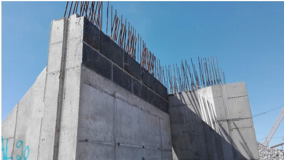
Kuva 10. Elementtiin on asennettu koristekivet veden pinnan vaihtelun mukaisesti.
