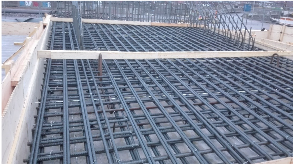
Kuva 5. Elementin pohja-osan valmis raudoitus ja nostolenkit.
