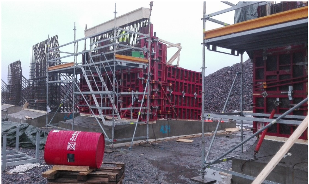
Kuva 9. Muottien viimeistelyssä tarvitaan myös aputasoja, jotta päästään käsiksi elementtien yläosiin.
