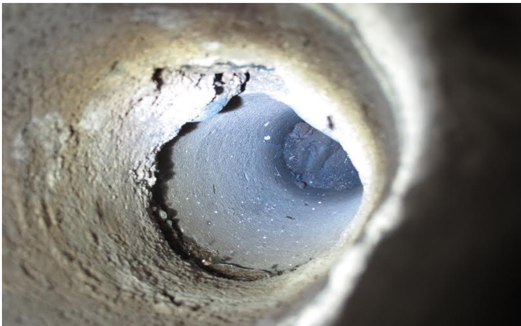
Kuva 25. Kuva otettu 22.4.2017. Edelleen kaivon kuiva vettä ei näy mutta betoni on hieman kosteudesta johtuen tummaa noin 10 cm matkalta. /21/
