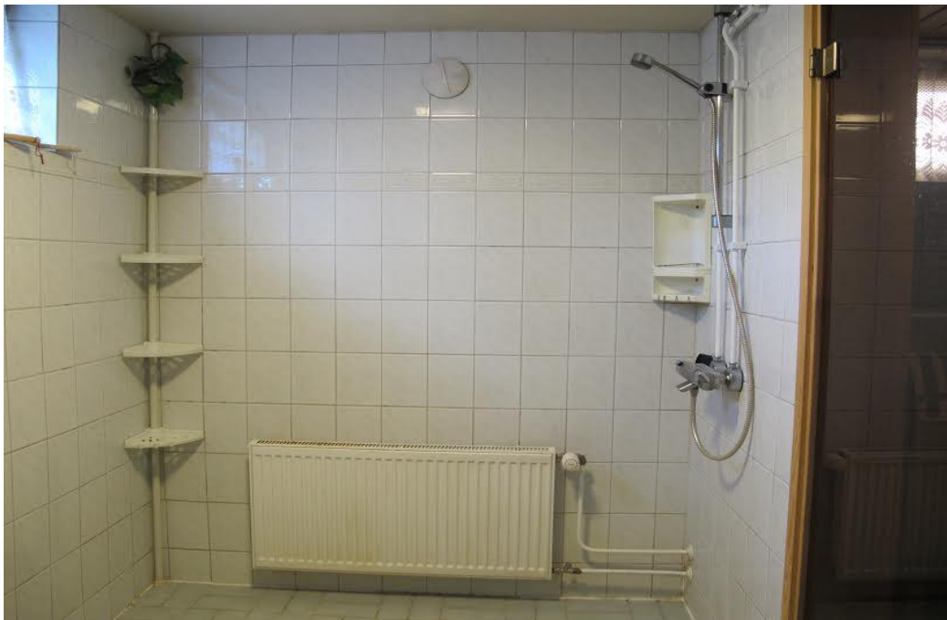
Kuva 22. Kuva pesuhuoneesta huhtikuussa 2017. /21/
