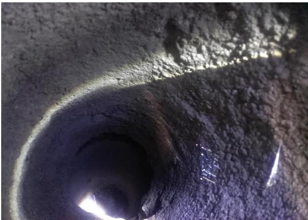
Kuva 24. Kuva otettu 1.4.2017 kaivon pohjalla ei näy vettä eikä muutenkaan merkkejä kosteudesta. /21/
