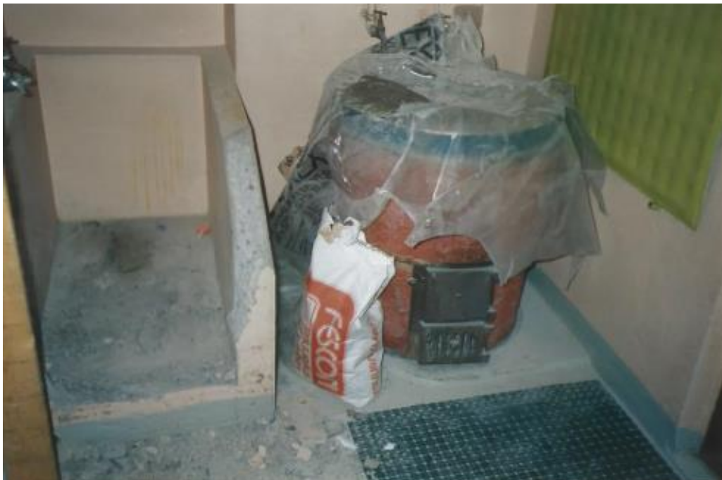
Kuva 15. Kuvassa on alkuperäinen tilanne eli vesipata ja allas, joka oli valettu betonista. /21/
