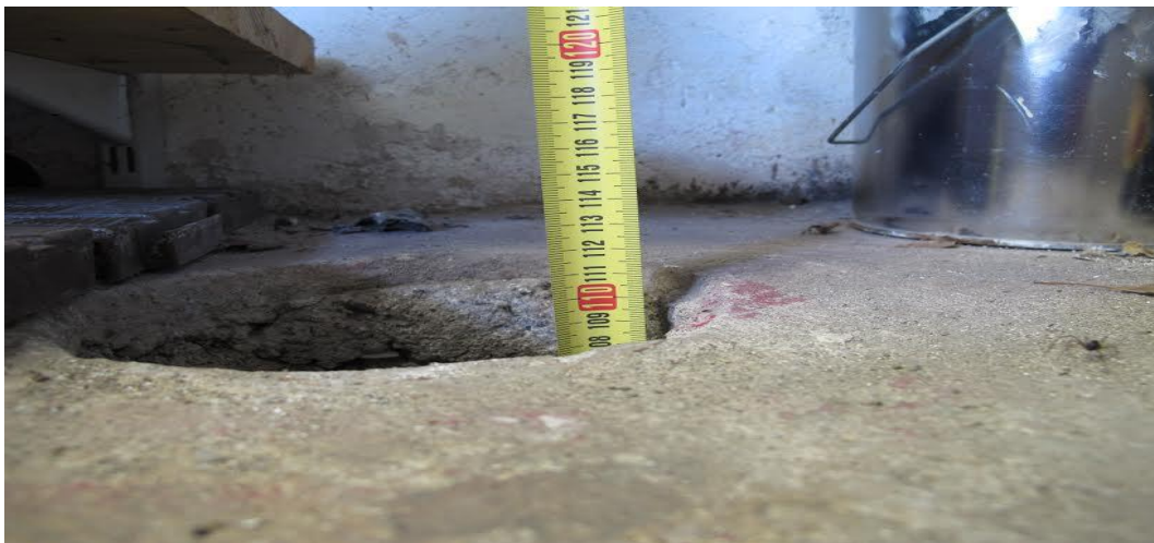
Kuva 23. Kuvasta ilmenee autotallissa oleva tarkastuskaivon syvyys. /21/
